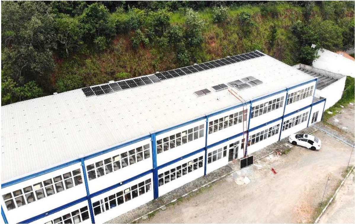
Figura 38 - Instalação das placas fotovoltaicas.
