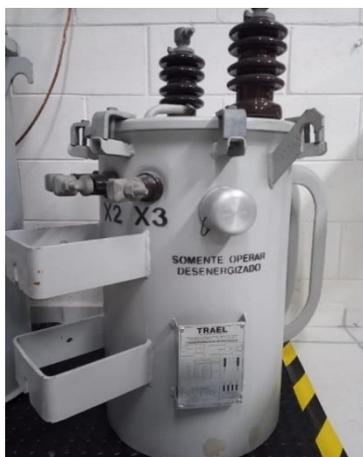
Figura 12 - Transformador bifásico UNIFAAT
