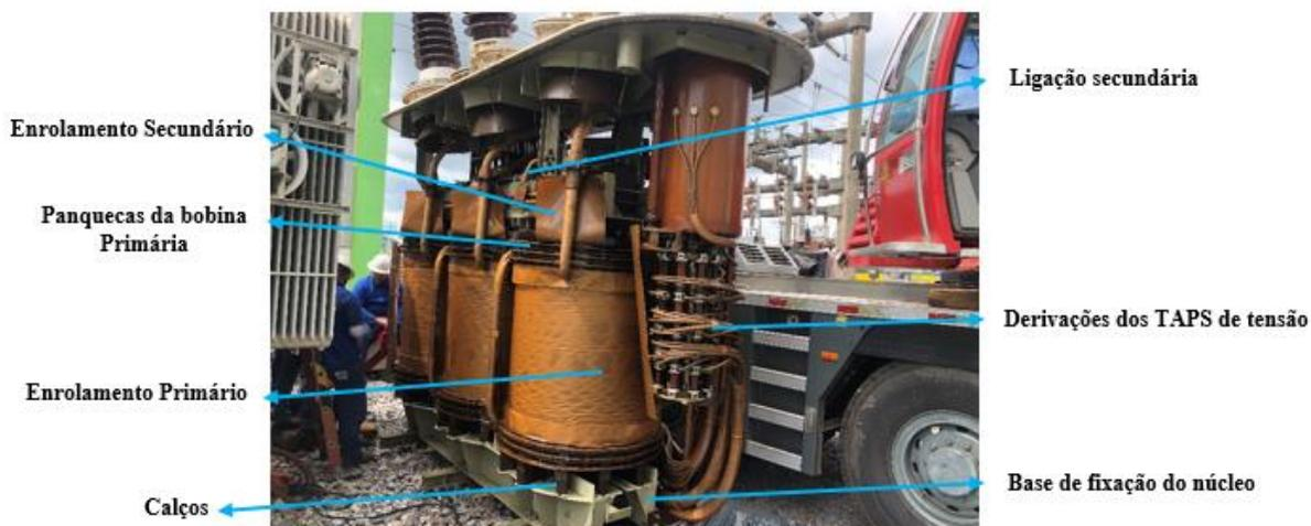
Figura 10 - Núcleo de um transformador trifásico
