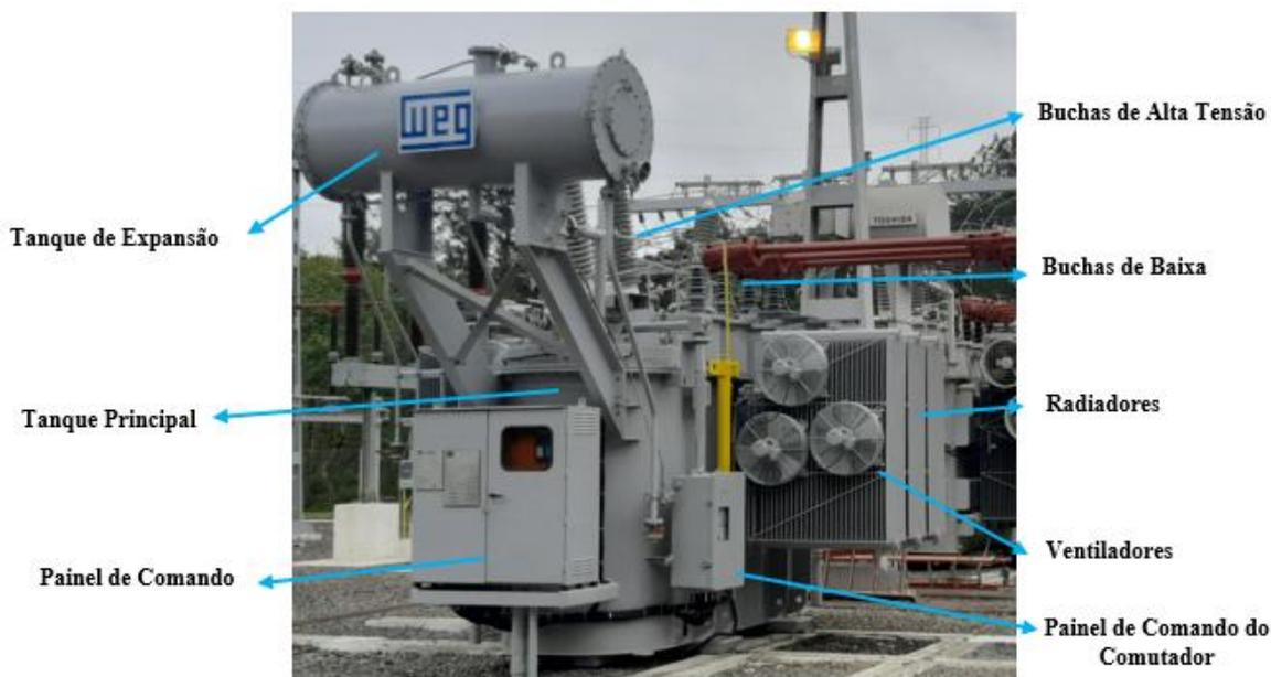
Figura 9 - Transformador
