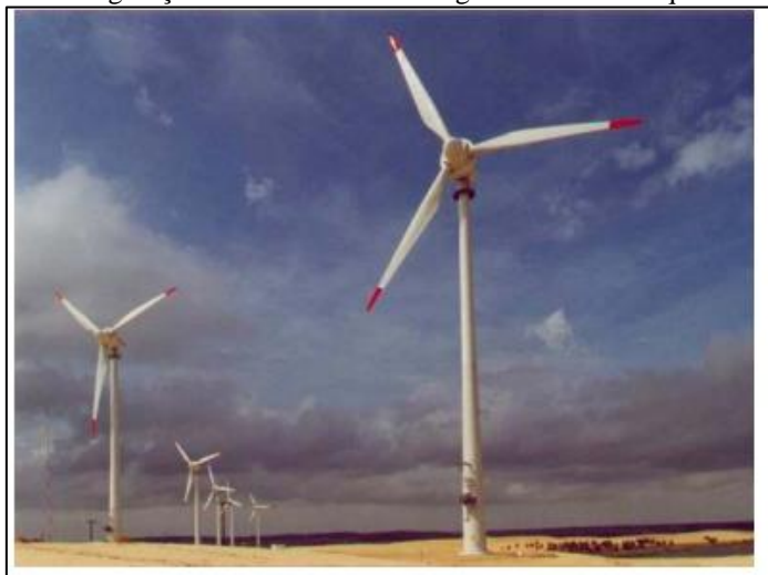
Figura 70 - Configuração de um sistema interligado à rede – Parque Eólico da Prainha – CE
