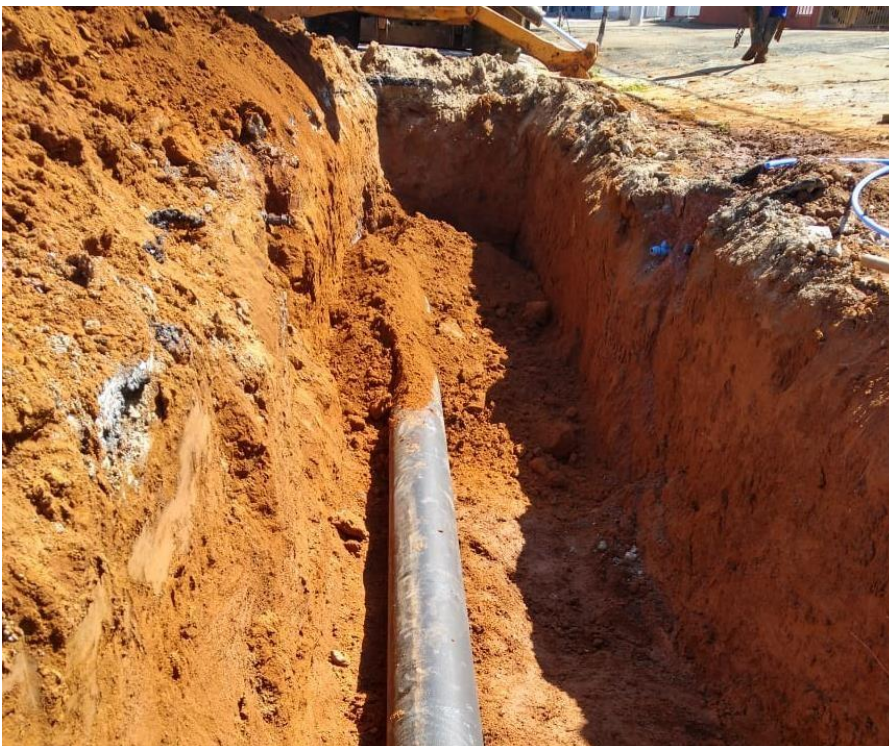
Figura 22 - Rede de ferro fundido
