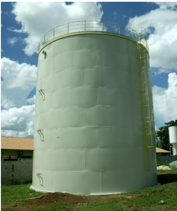
Figura 16 - Reservatório de água
