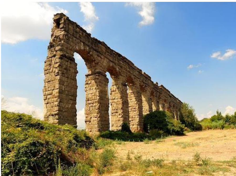
Figura 2 - Aqueduto romano Aqua Claudia
