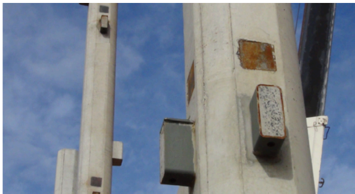
Figura 9 – Consolo de perfil metálico embutido
