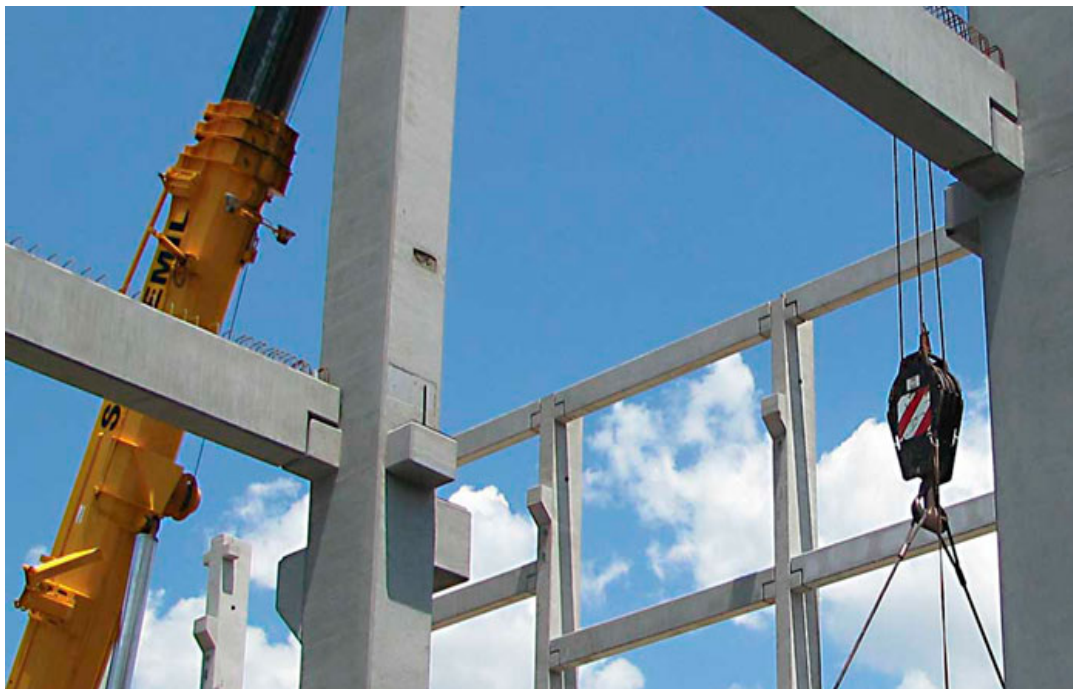
Figura 2 - Sistema estrutural pré-fabricado atualmente
