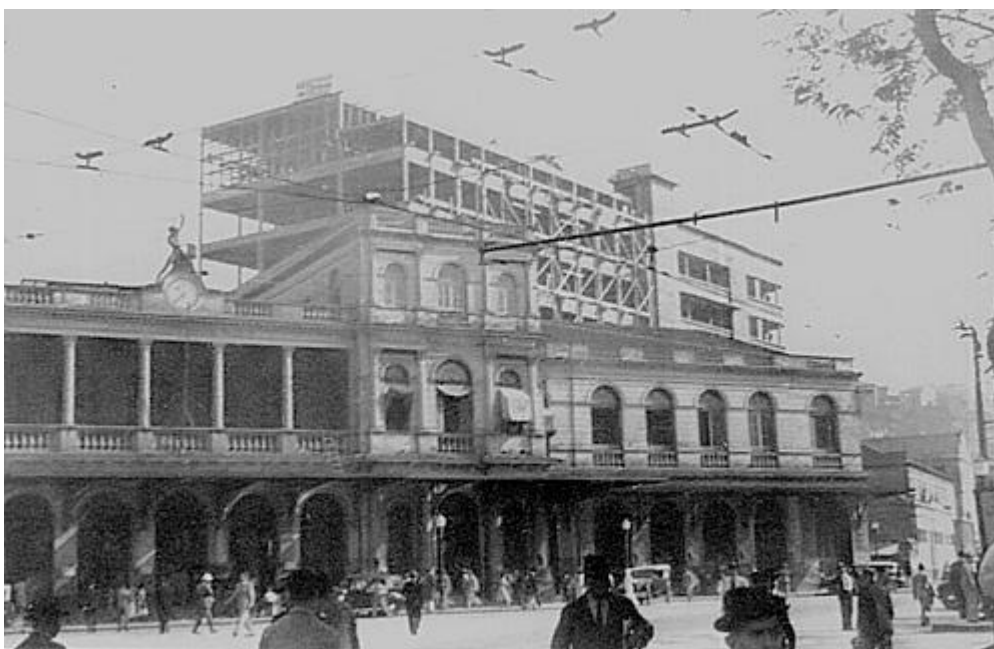
Figura 1 - Primeira Construção pré-fabricada do Brasil
