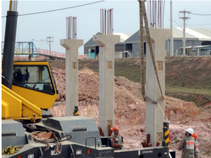
Figura 7 - Consolo duplo em canteiro
