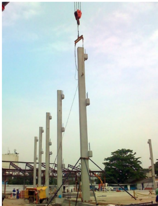
Figura 8 – Consolos implementados para multipavimentos
