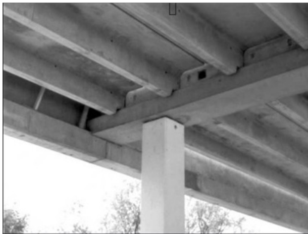
Figura 4 - Ligação viga-pilar de extremidade (Tipo II).
