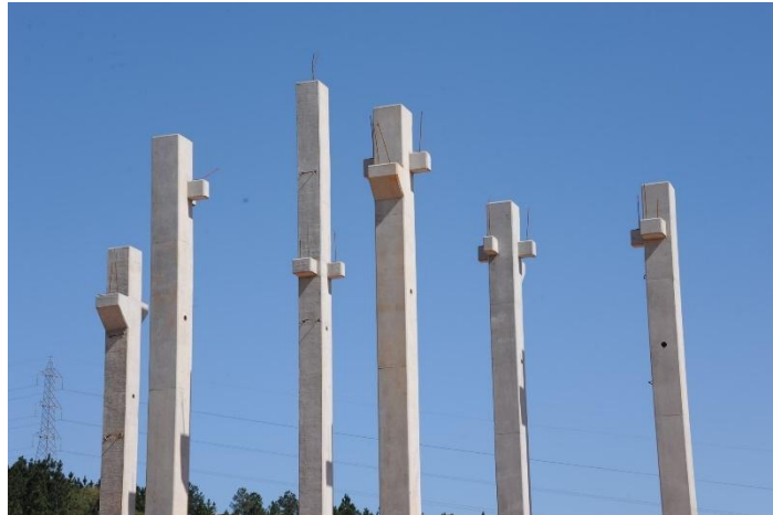
Figura 6 – Tipos de pilares Pré-fabricados
