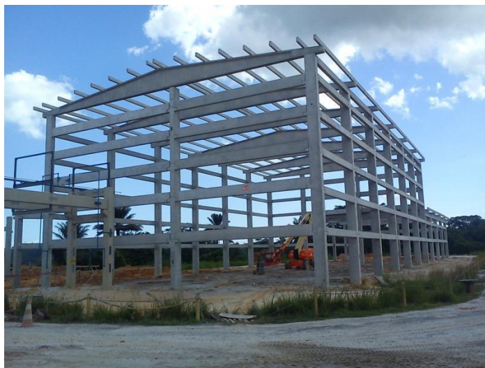
Figura 2 – Galpão em Pré-Moldado
