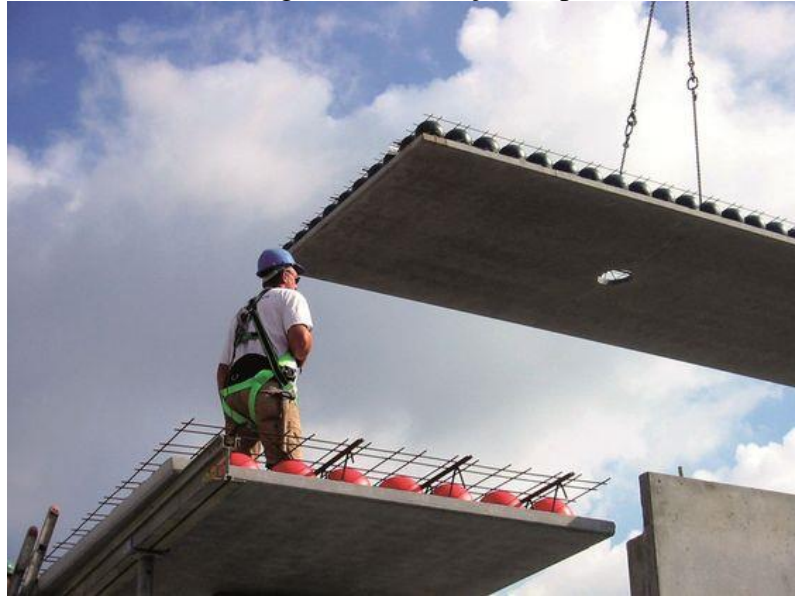
Figura 9: Colocação de painéis
