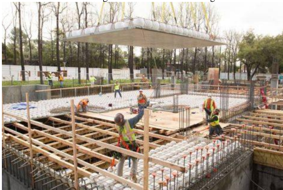
Figura 8: Escoramento de Vigas
