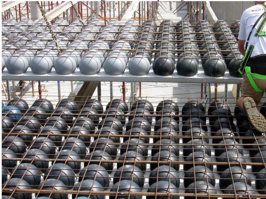
Figura 10: Reforço nas juntas
