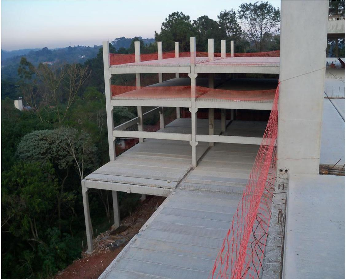
**Figura 28 - Ilustração de um edifício em concreto pré-fabricado - Green Reality
