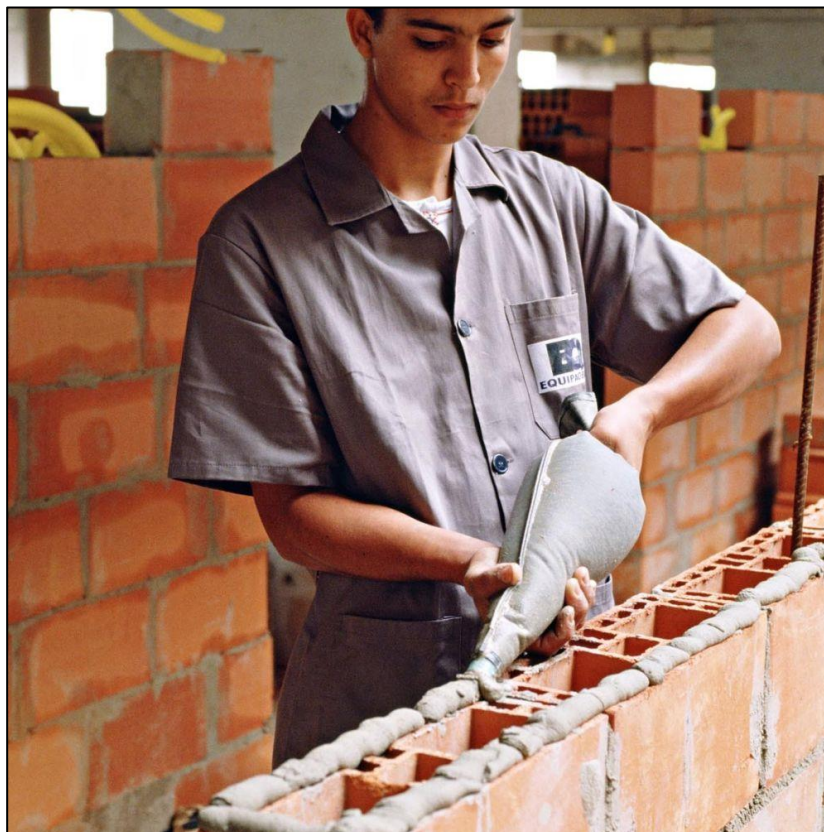
Figura 8: Aplicação de argamassa
