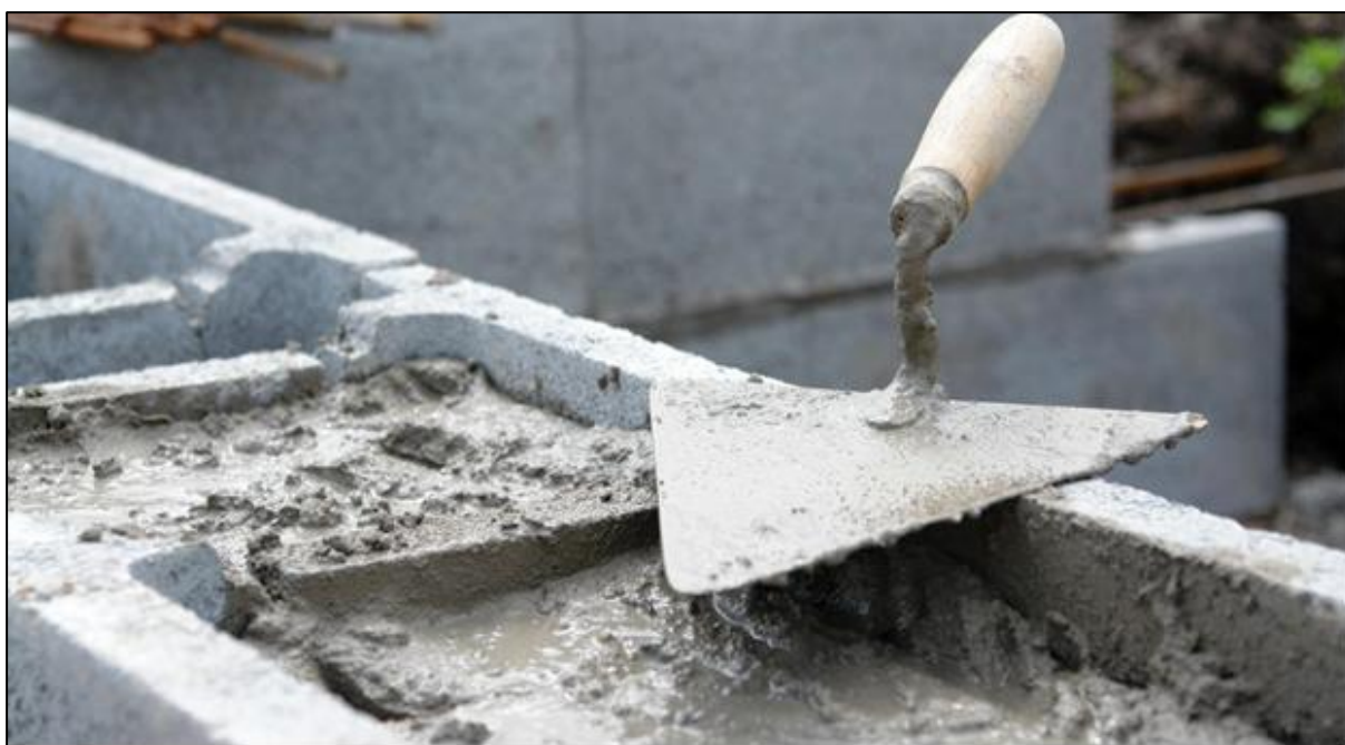
Figura 9: Execução do graute
