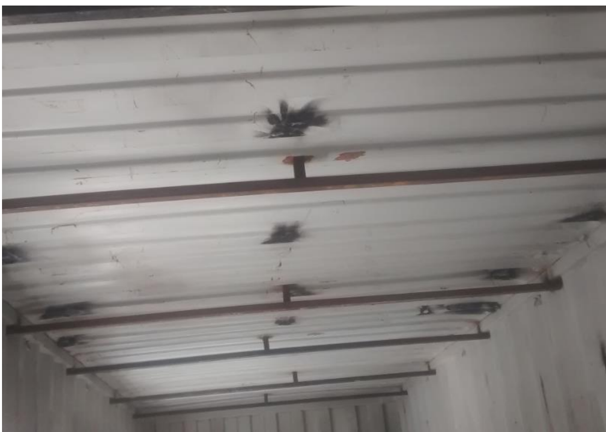
Figura 29: Suporte para fixar perfis.
