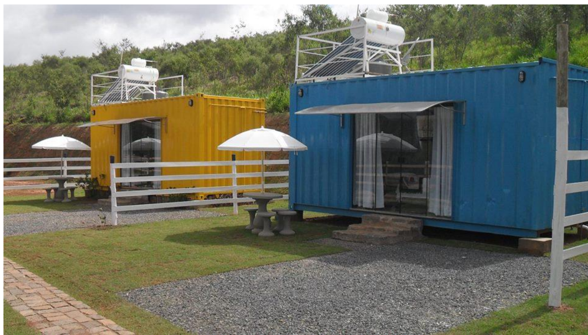
Figura 16: Quartos feitos de contêiner.
