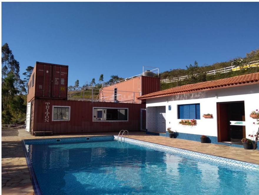
Figura 35: Vista da nova construção de contêineres.
