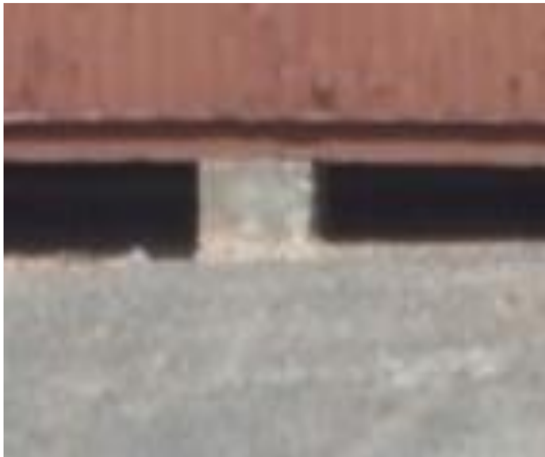
Figura 23: Bloco de fundação.
