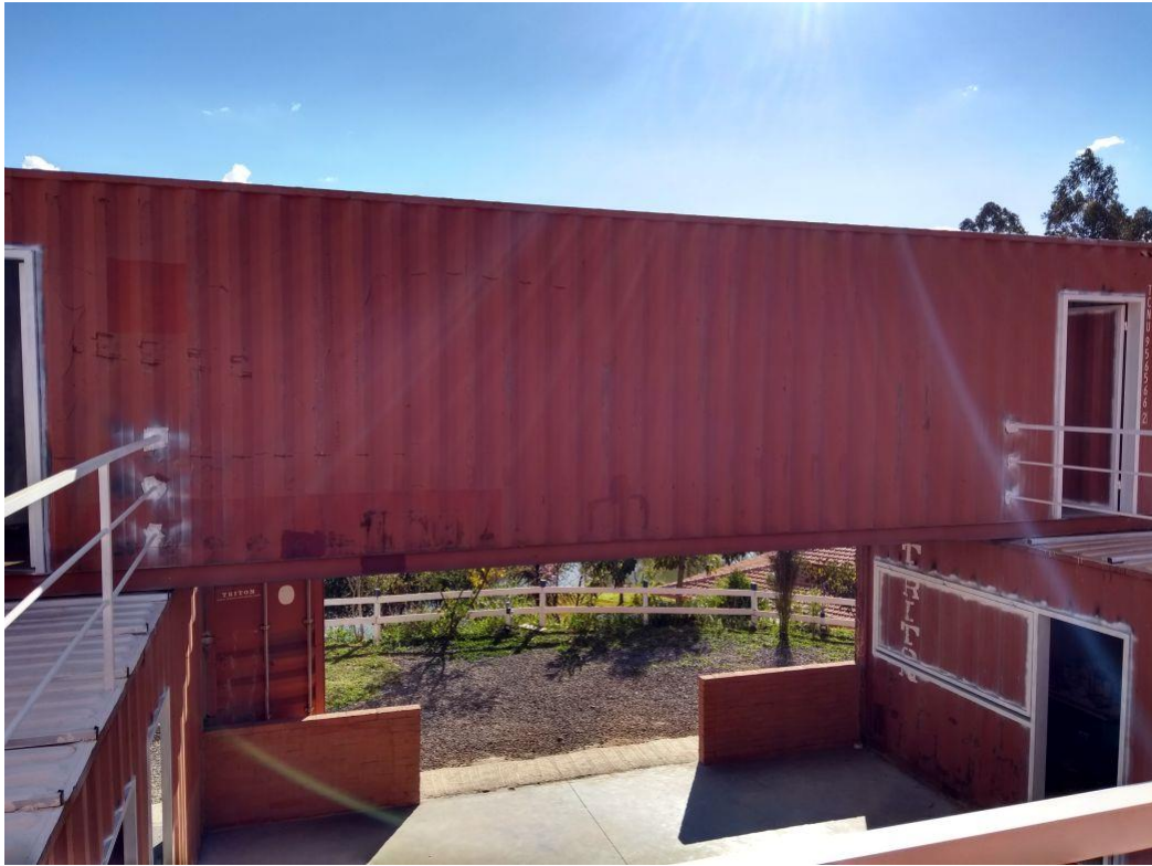
Figura 39: Vista de cima de um dos contêineres.
