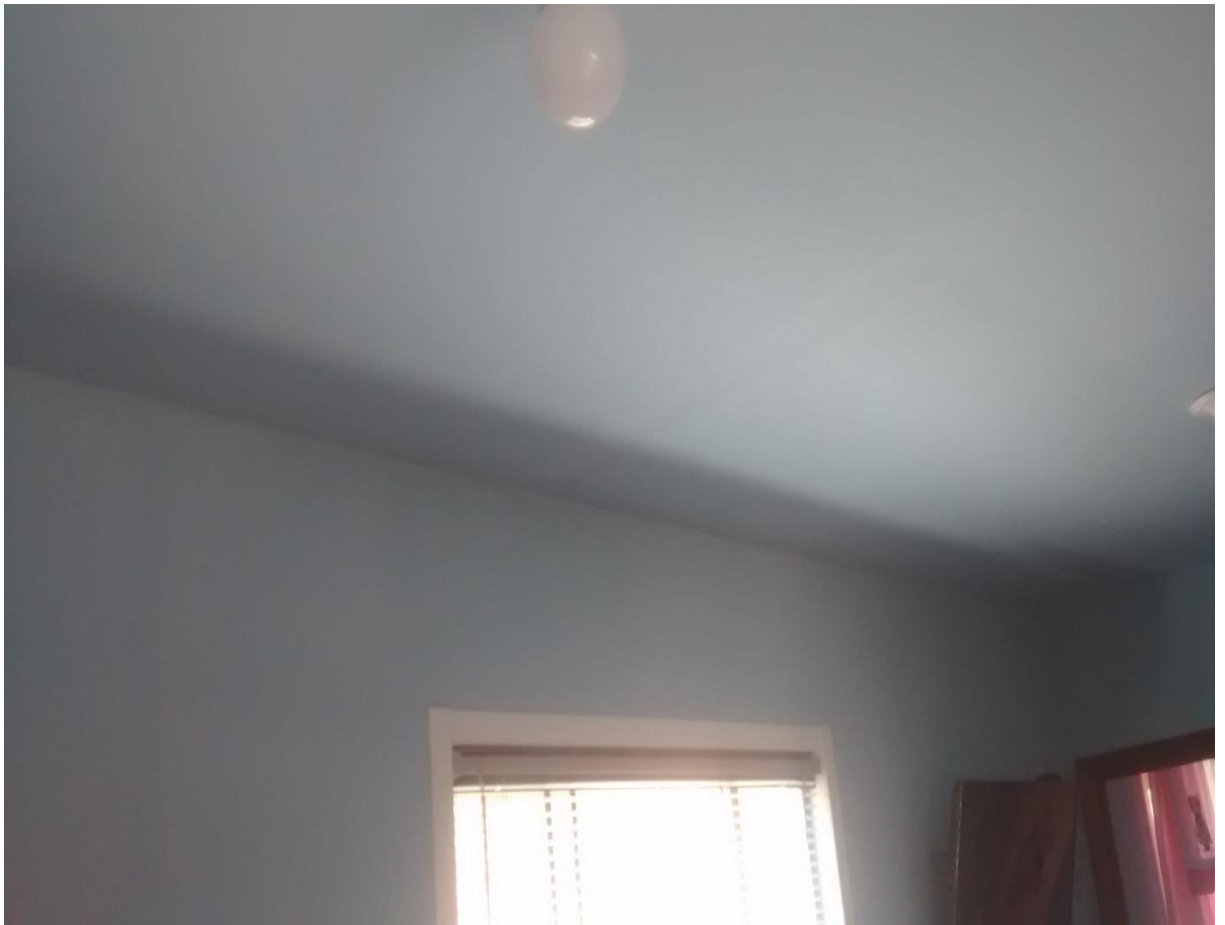
Figura 34: Acabamento de placa de gesso.
