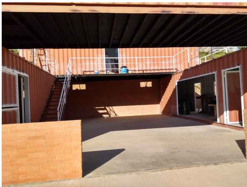
Figura 36: Vista do térreo da construção.
