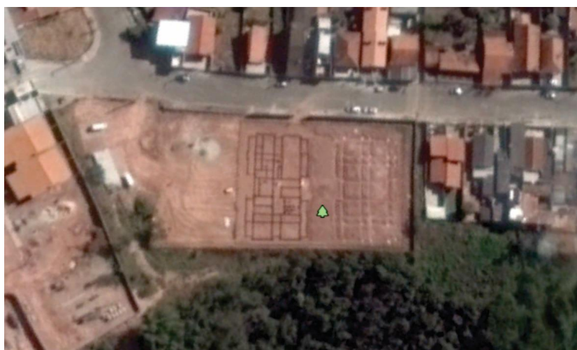
Figura 02: Vista aérea do terreno por satélite
