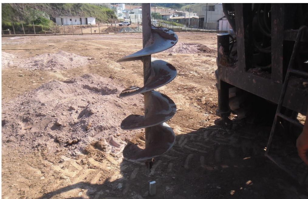
Figura 05: Estaca sendo retirada do solo
