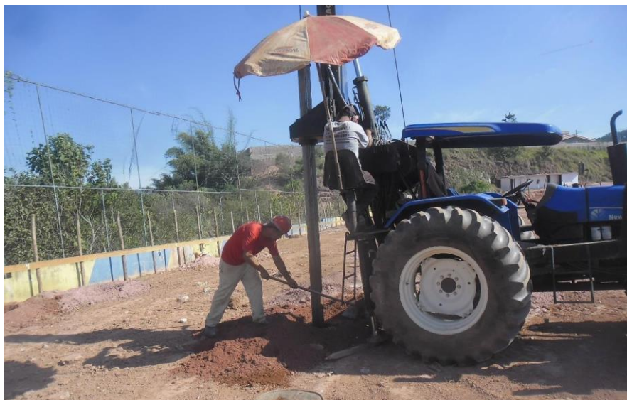
Figura 04: Processo de cravação da estaca
