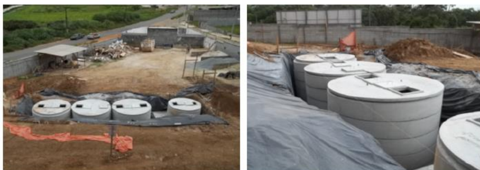
Figura 13: Sistema em construção - Reservatórios inferiores
