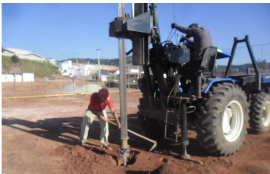
Figura 03: Estaca tipo Strauss/ Hélice contínua
