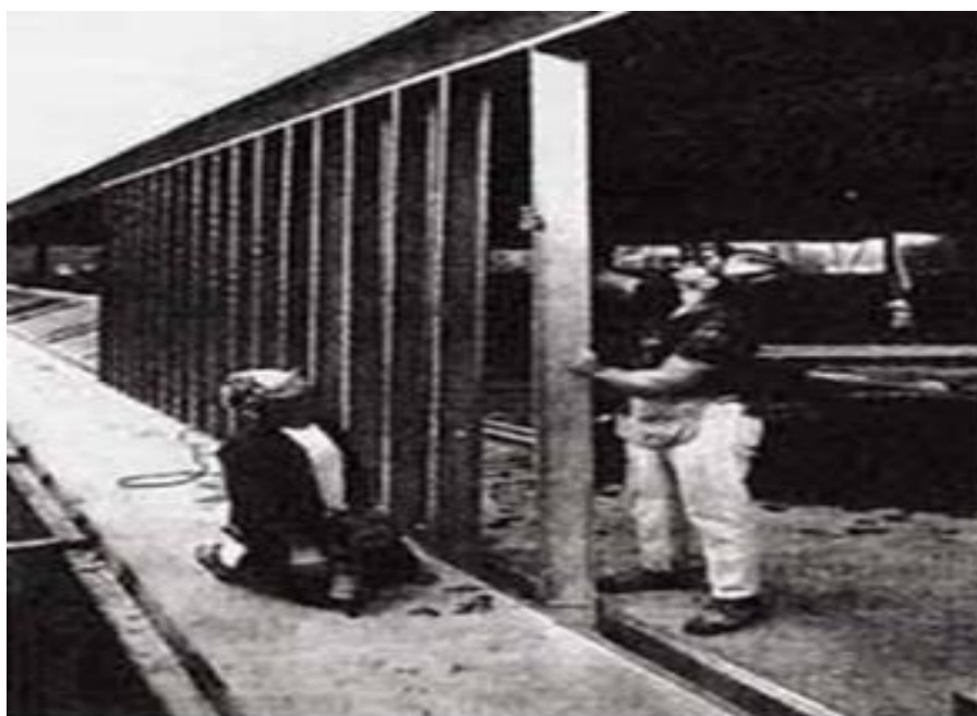
Figura 21: Montagem método Stick
