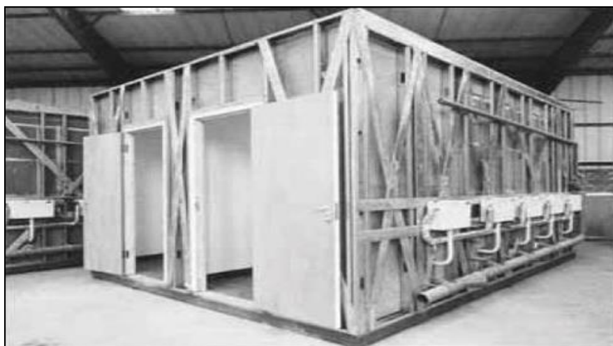
Figura 23: Montagem por Construção Modular
