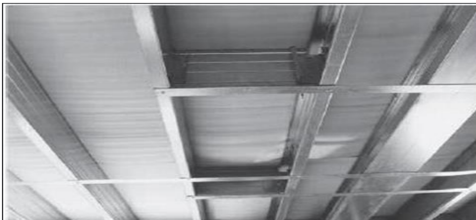
Figura 19: Travamento horizontal da laje de piso por meio de bloqueadores e fitas metálicas.
