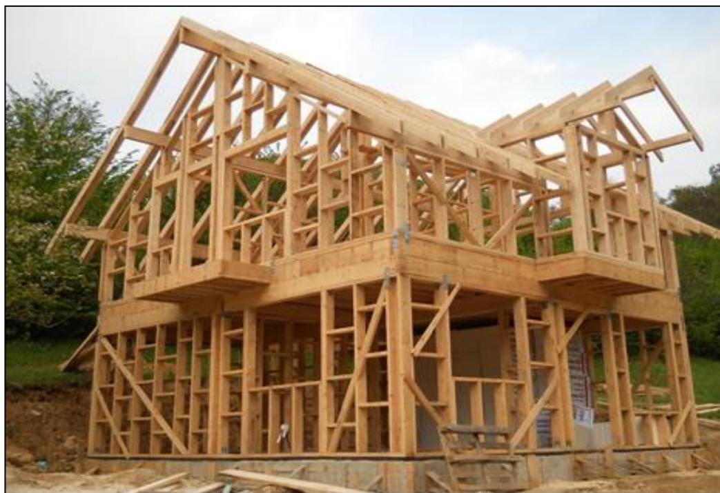
Figura 1: Sistema construtivo Wood Frame
