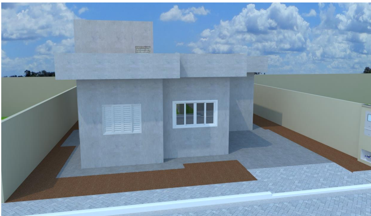
Figura 47: Placa cimentícia com esquadrias.
