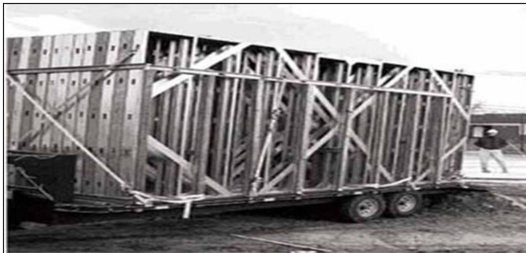
Figura 22: Montagem por painéis
