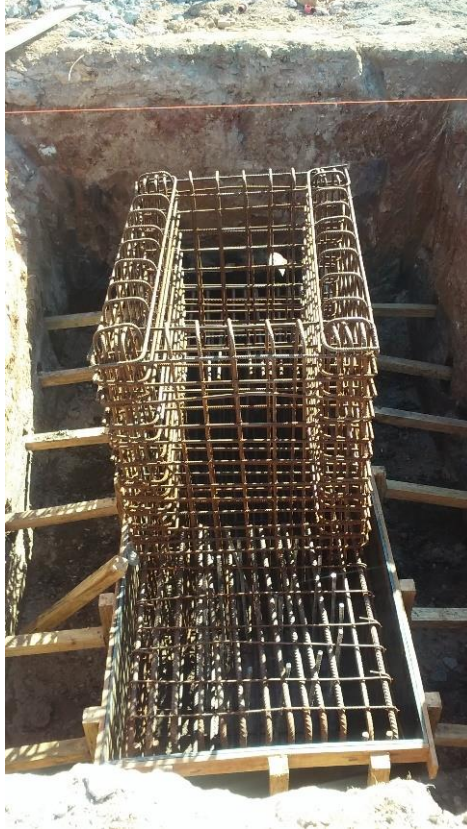
Figura 29 – Armação de bloco sobre duas estacas
