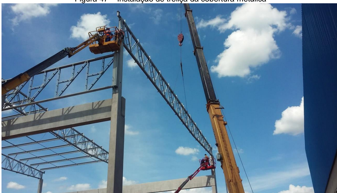
Figura 47 – Instalação de treliça da cobertura metálica
