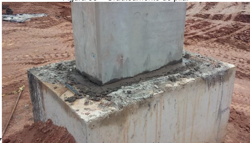
Figura 38 – Grauteamento de pilar
