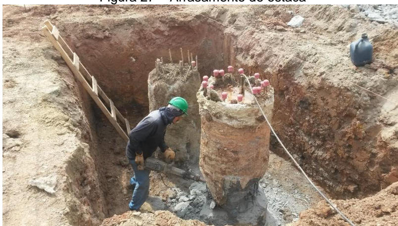
Figura 27 – Arrasamento de estaca
