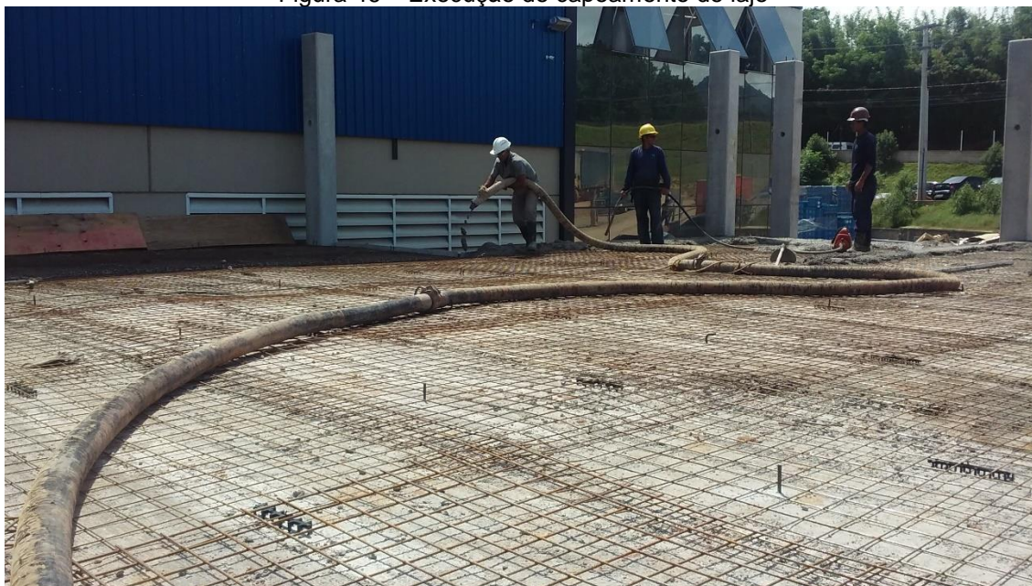
Figura 46 – Execução de capeamento de laje
