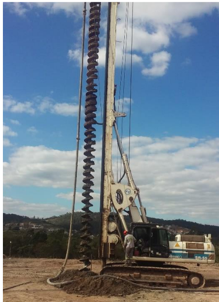
Figura 26 – Perfuratriz estaca hélice contínua
