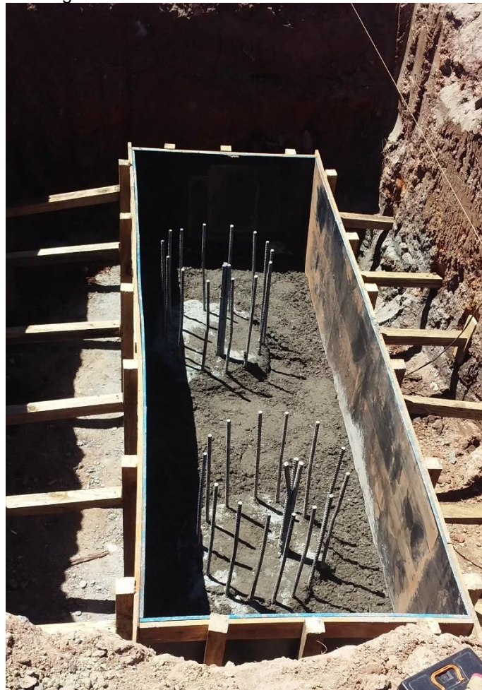
Figura 28 – Forma de bloco sobre duas estacas
