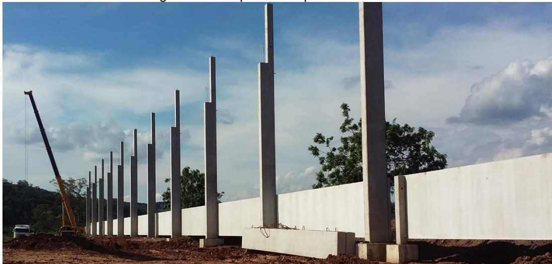
Figura 42 – Sequência de painéis montados
