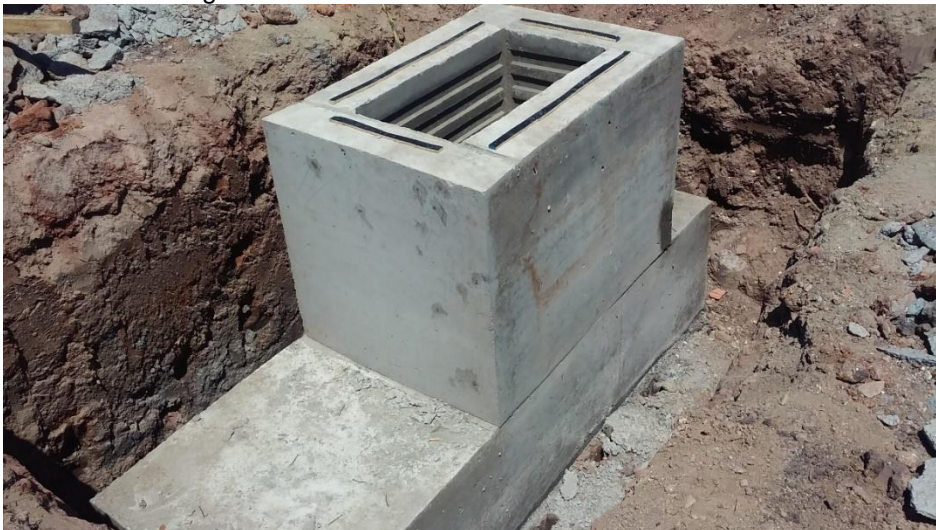
Figura 30 – Bloco sobre duas estacas concretado
