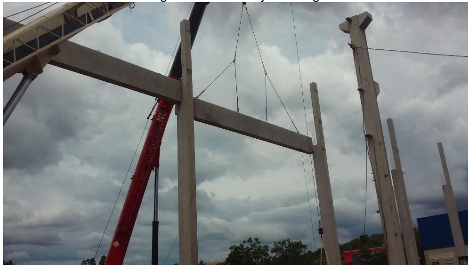
Figura 39 – Instalação de viga
