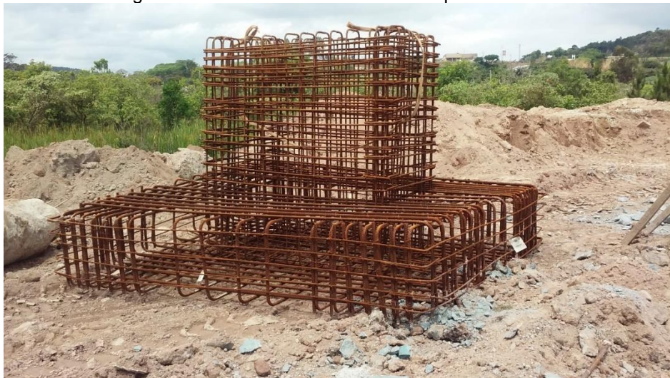
Figura 34 – Armadura de bloco sobre quatro estacas
