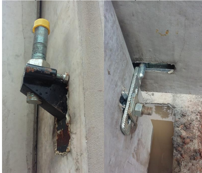
Figura 41 – Dispositivos de fixação de painel
