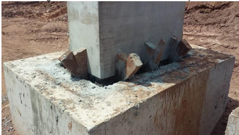
Figura 37 – Detalhe de encunhamento de pilar
