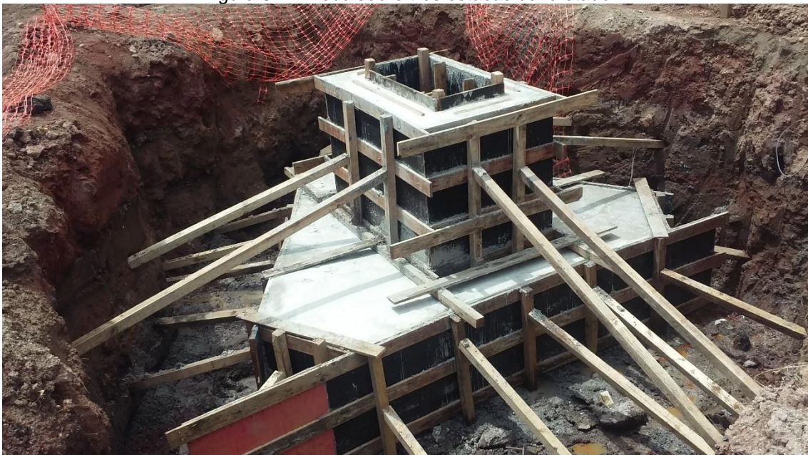
Figura 32 – Bloco sobre três estacas concretado
