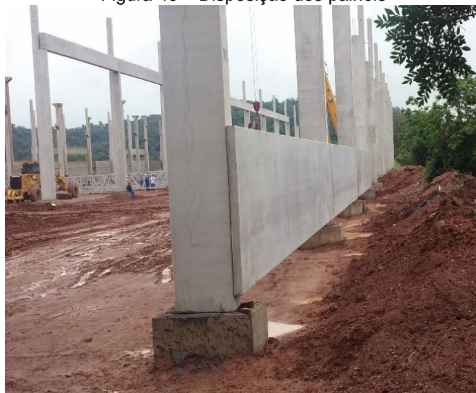
Figura 40 – Disposição dos painéis
