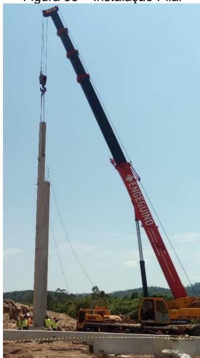
Figura 36 – Instalação Pilar
