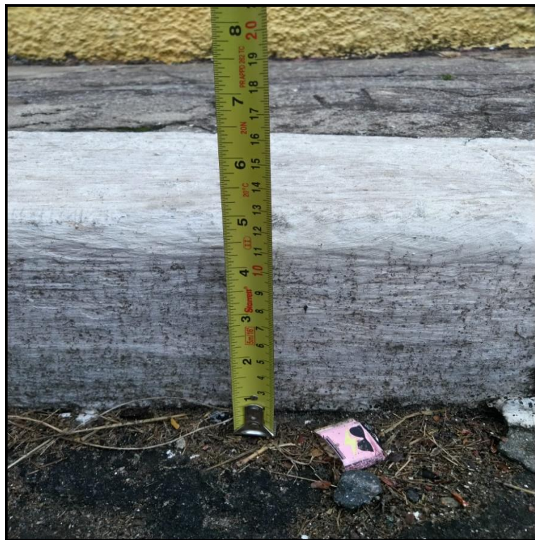
Figura 81: Medidas de sarjetas sem regularidade.
