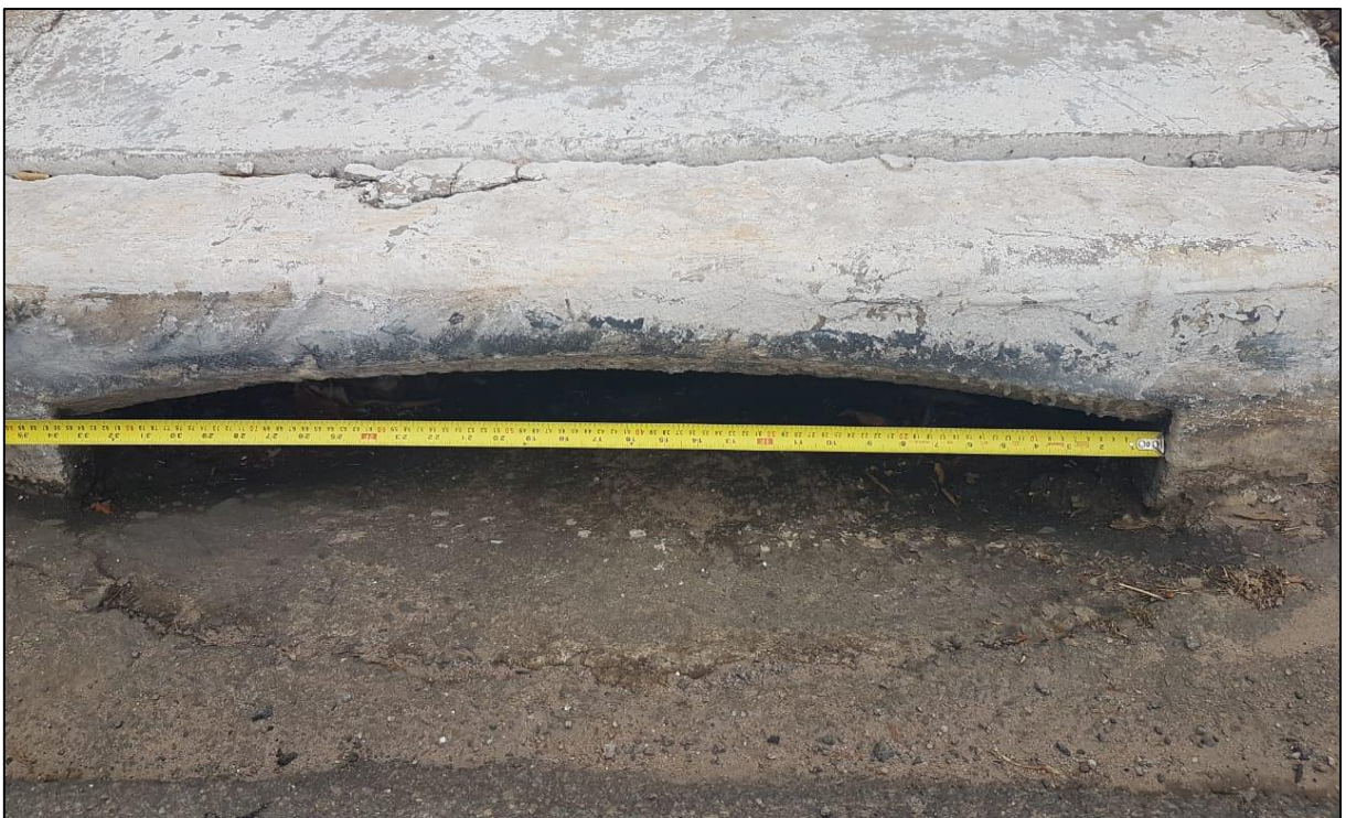
Figura 87: Abertura de boca de lobo sendo medida.
