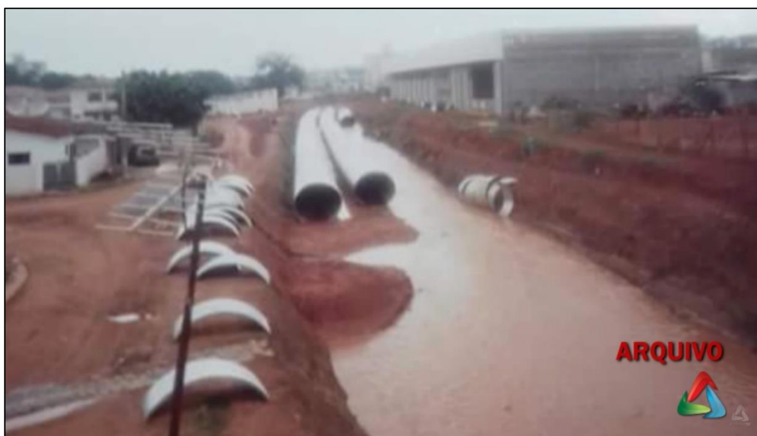
Figura 25: Obra de canalização córrego Piqueri
