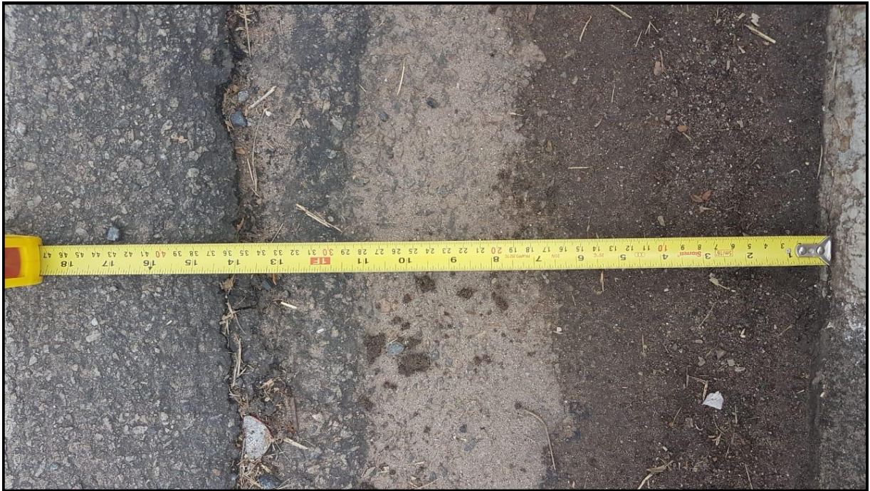
Figura 82: Medidas de sarjetas sem regularidade.
