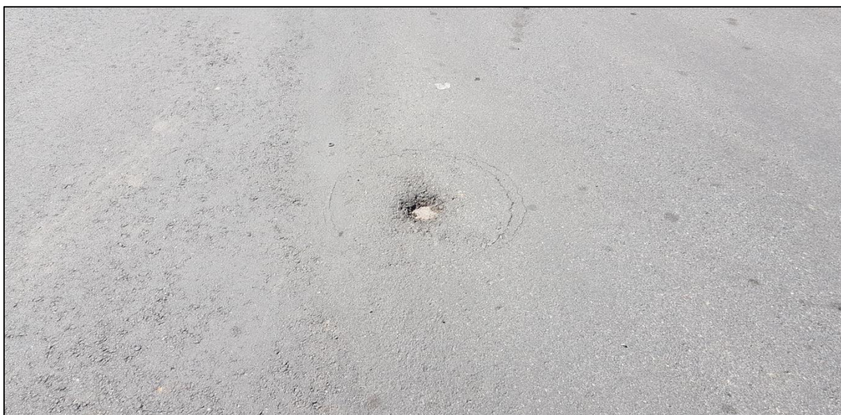
Figura 65: Poço de visita sob a camada de rolamento
