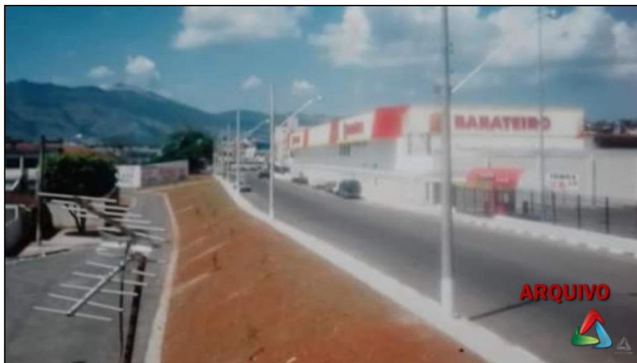
Figura 26: Avenida Gaspar Camargo após canalização
