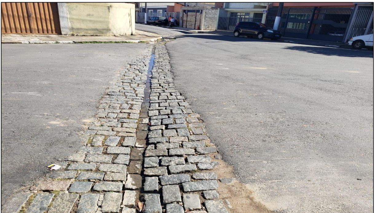
Figura 60: Sarjetão em paralelepípedo
