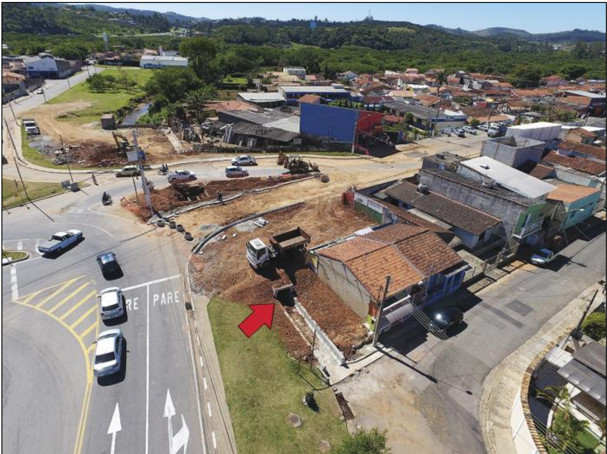
Figura 34: Vista superior das Aduelas do bairro ao riacho
