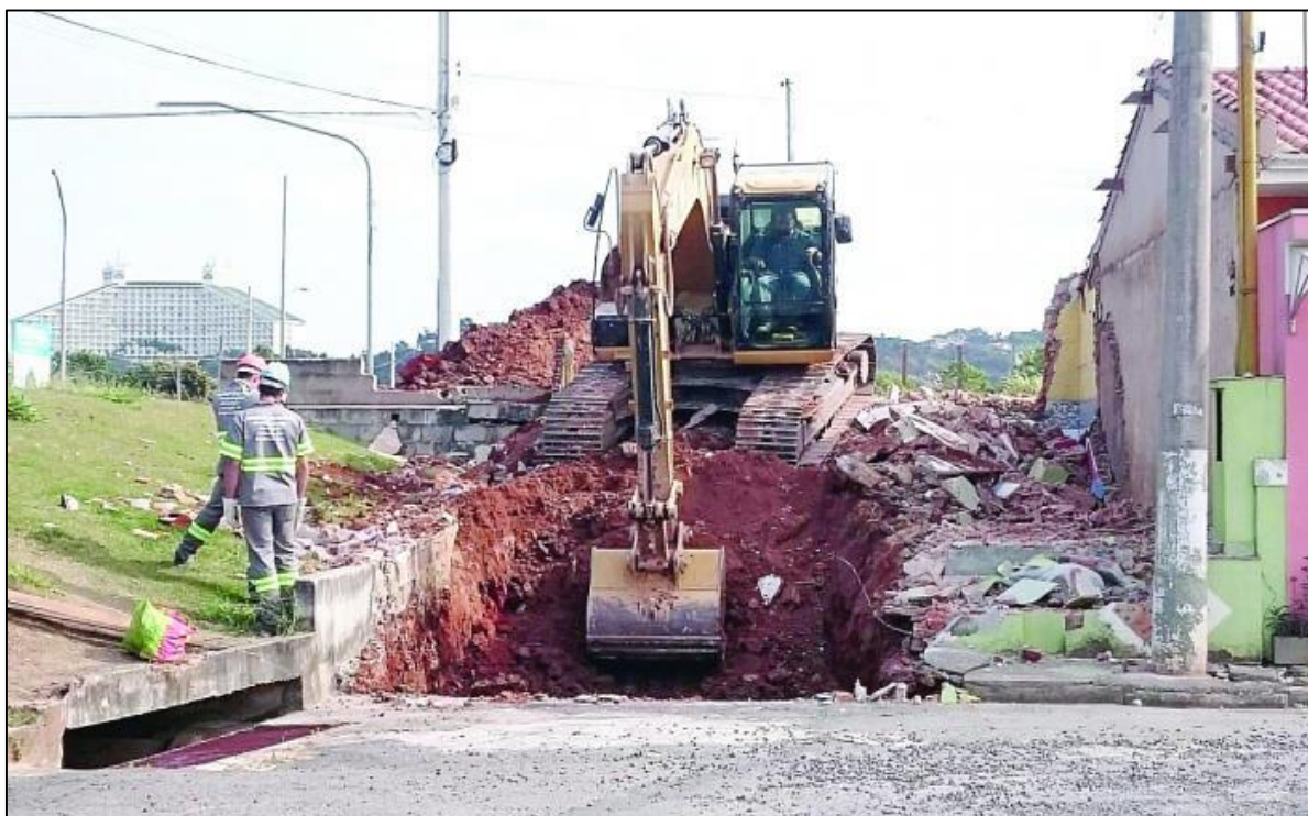
Figura 35: Casa desapropriada para execução das aduelas
