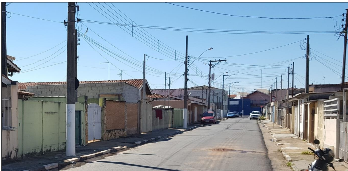
Figura 66: Rua sem galerias de drenagem
