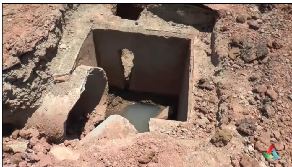
Figura 31: Galeria antiga que foi desobstruída
