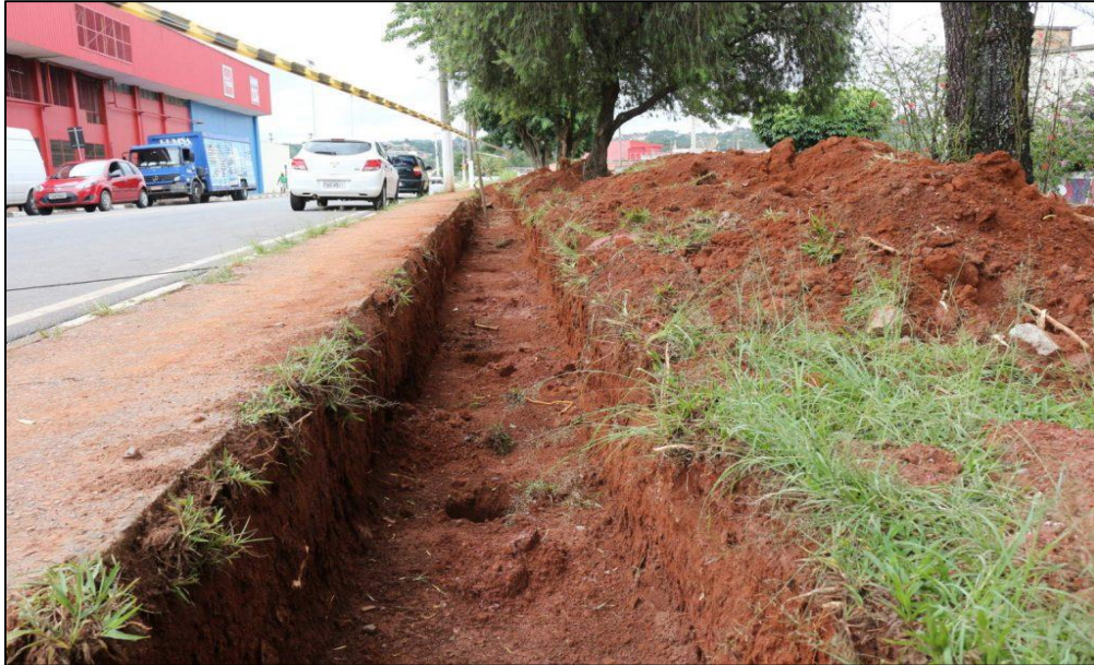
Figura 36: Vala aberta para execução do muro
