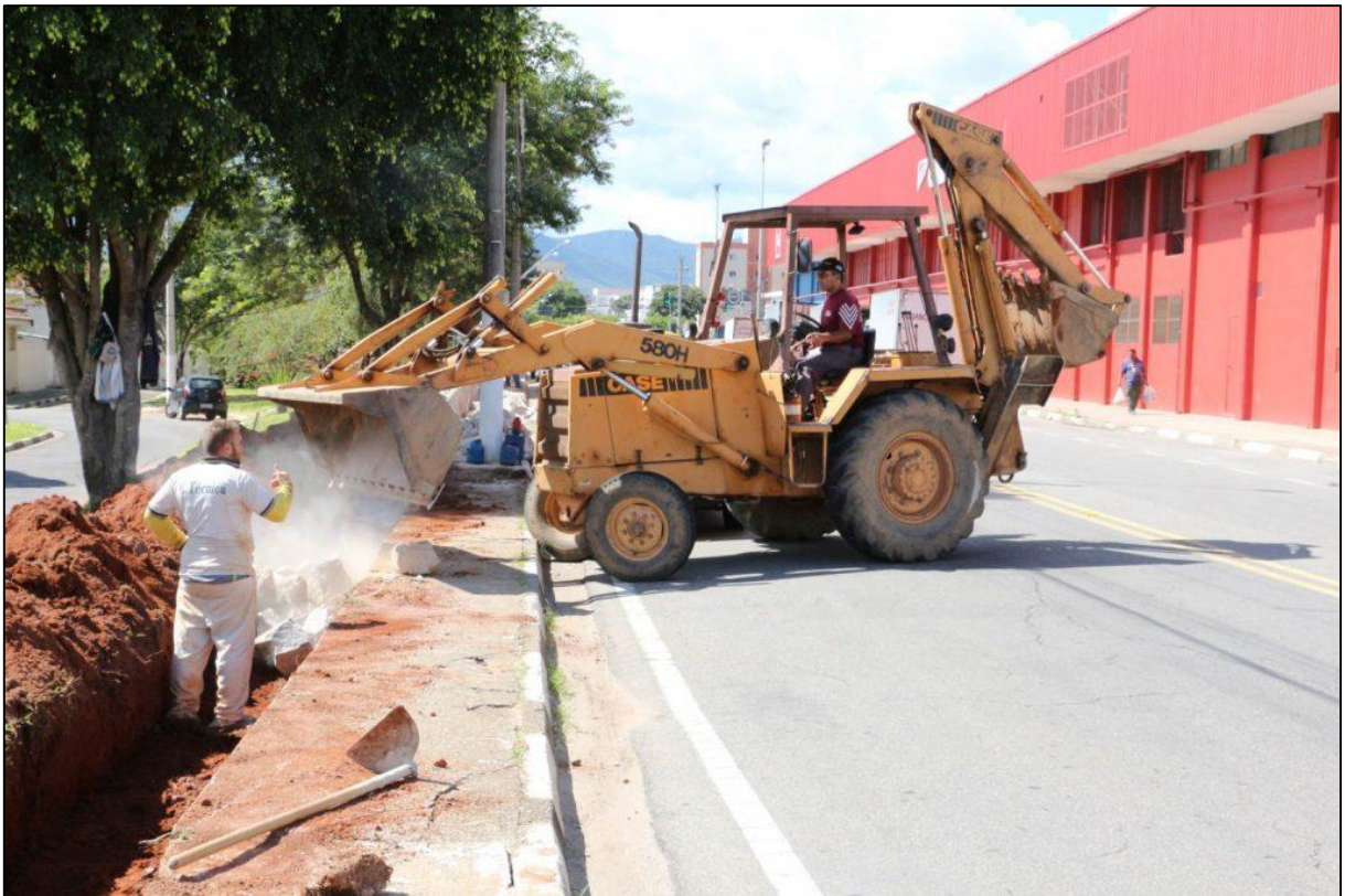
Figura 37: Pedras utilizadas no acabamento sendo depositadas
