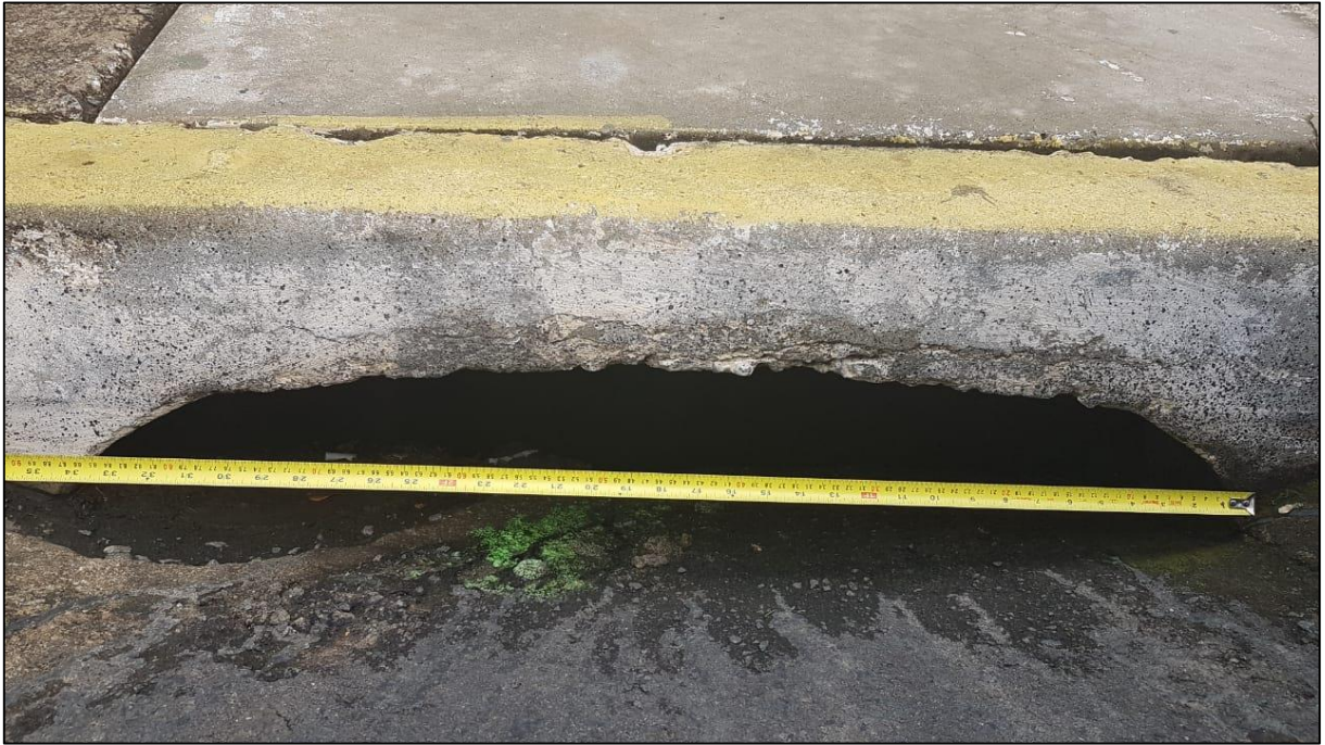
Figura 80: Abertura de boca de lobo sendo medida.
