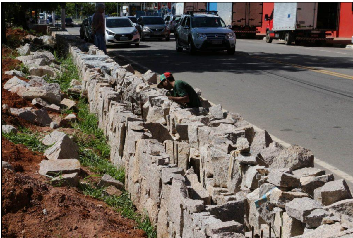
Figura 38: Muro em fase de concretagem
