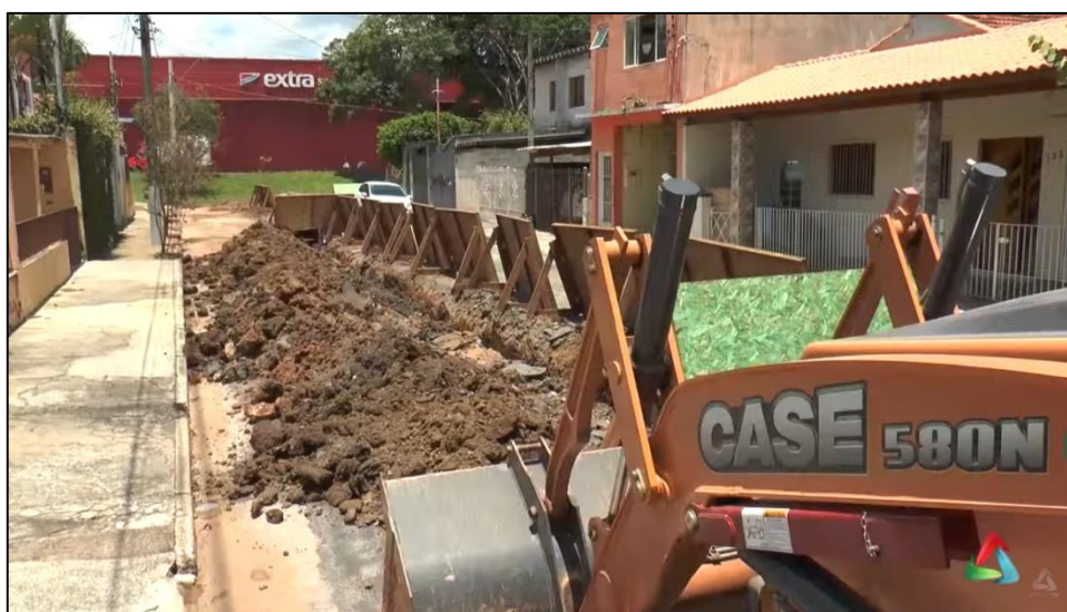
Figura 30: Colocação de novas tubulações
