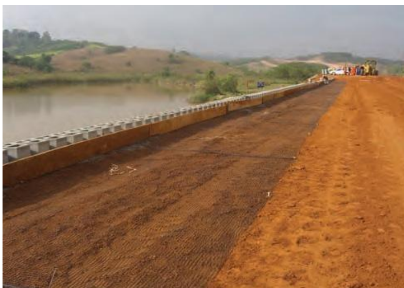
Figura 7: Aterro sobre solo mole.
