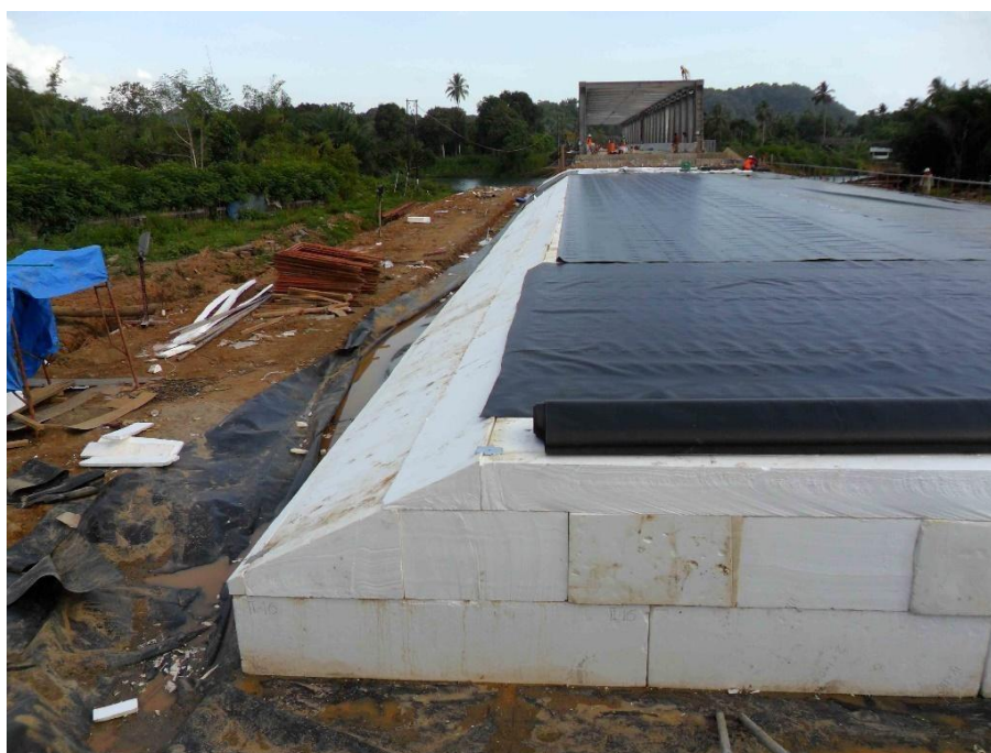
Figura 22: Utilização de blocos de EPS
