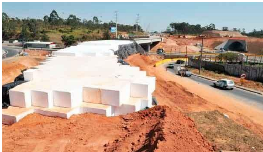
Figura 11: Aterro leve com EPS.
