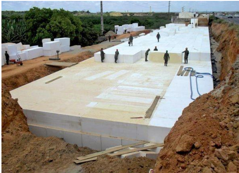
Figura 19: Aterro com blocos de EPS
