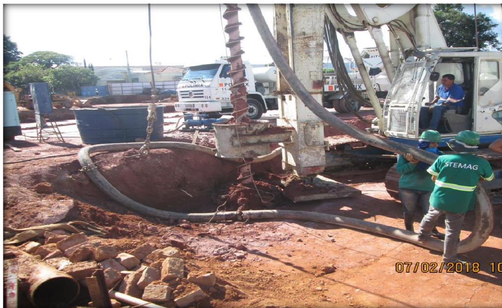
Figura 10 - Perfuração do terreno para execução da estaca hélice contínua.
