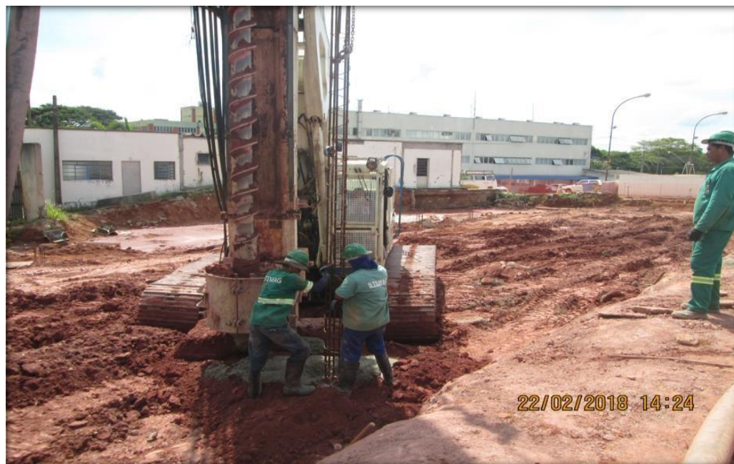
Figura 13 - Colocação da armadura manualmente.
