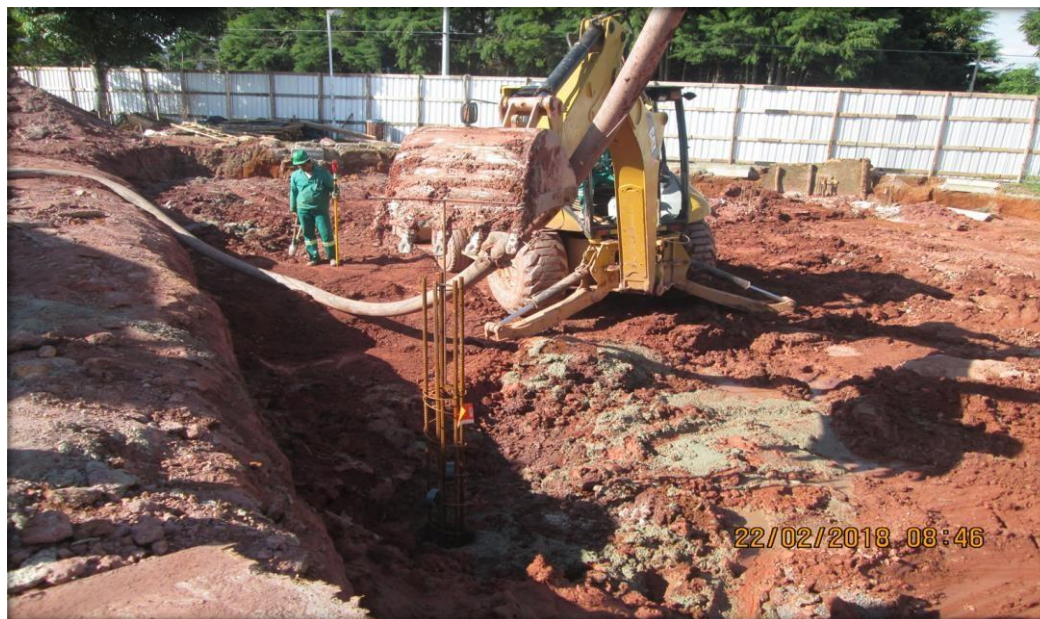
Figura 14 - Colocação da armadura longitudinal com o auxílio de uma retroescavadeira.
