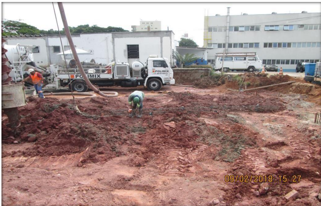
Figura 12 - Colocação das correntes para elevação das armaduras longitudinais das estacas
