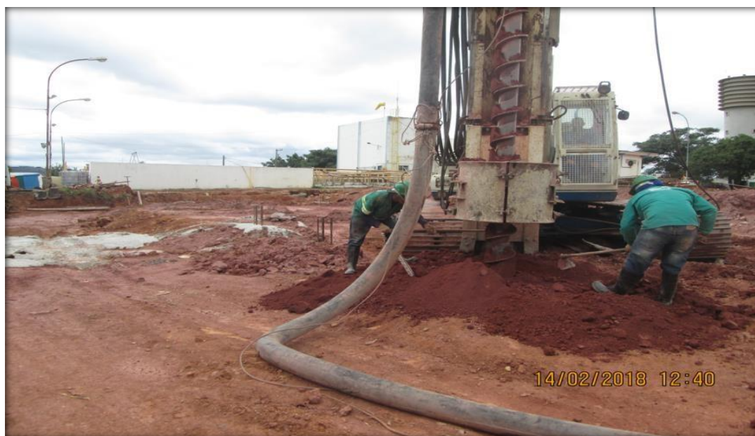
Figura 11 - Limpeza manual do solo contido no trado.
