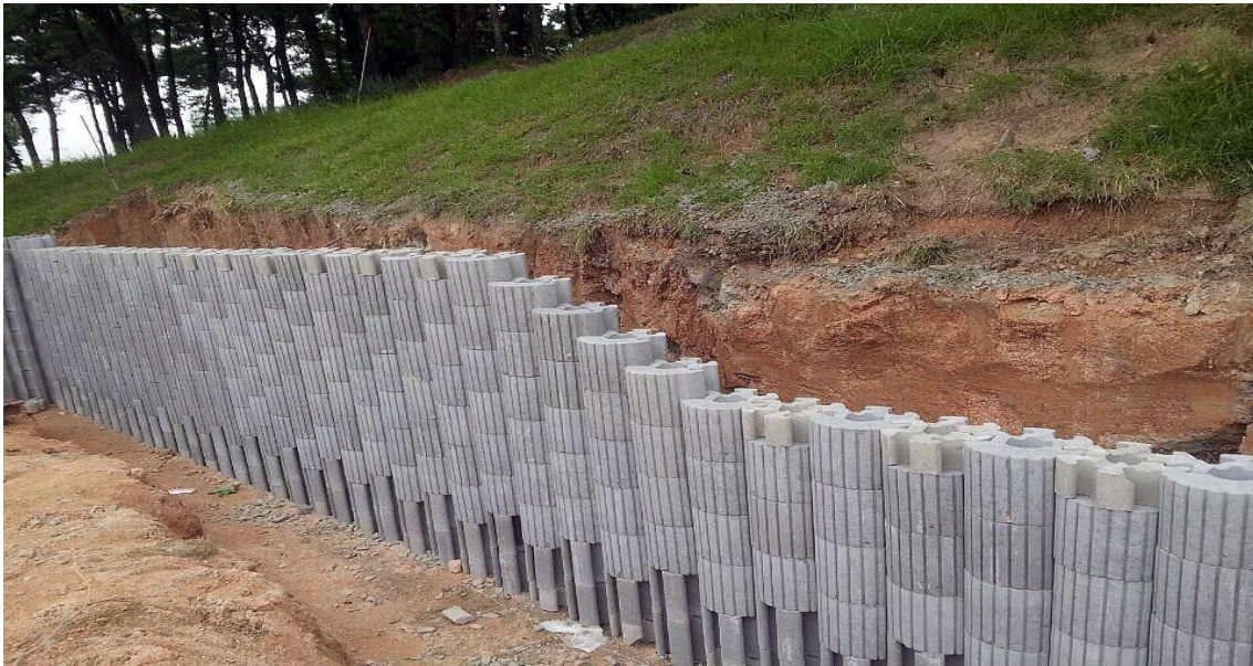
Figura 14 - Muro de arrimo com bloco de concreto
