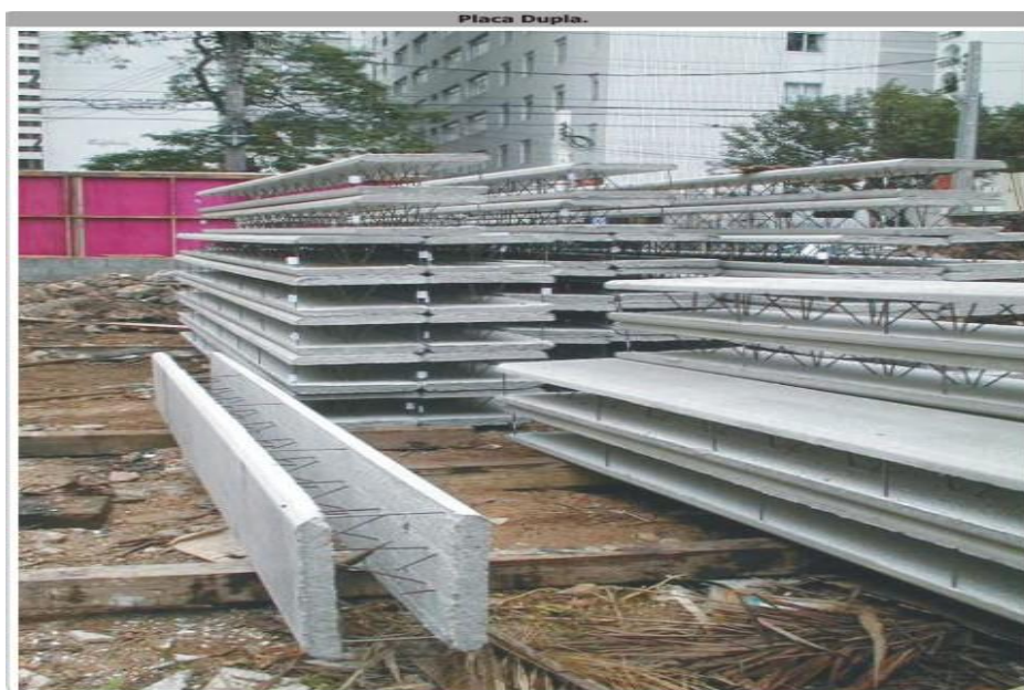
Figura 3 - Contenção pré-moldado tipo laje treliça peça
