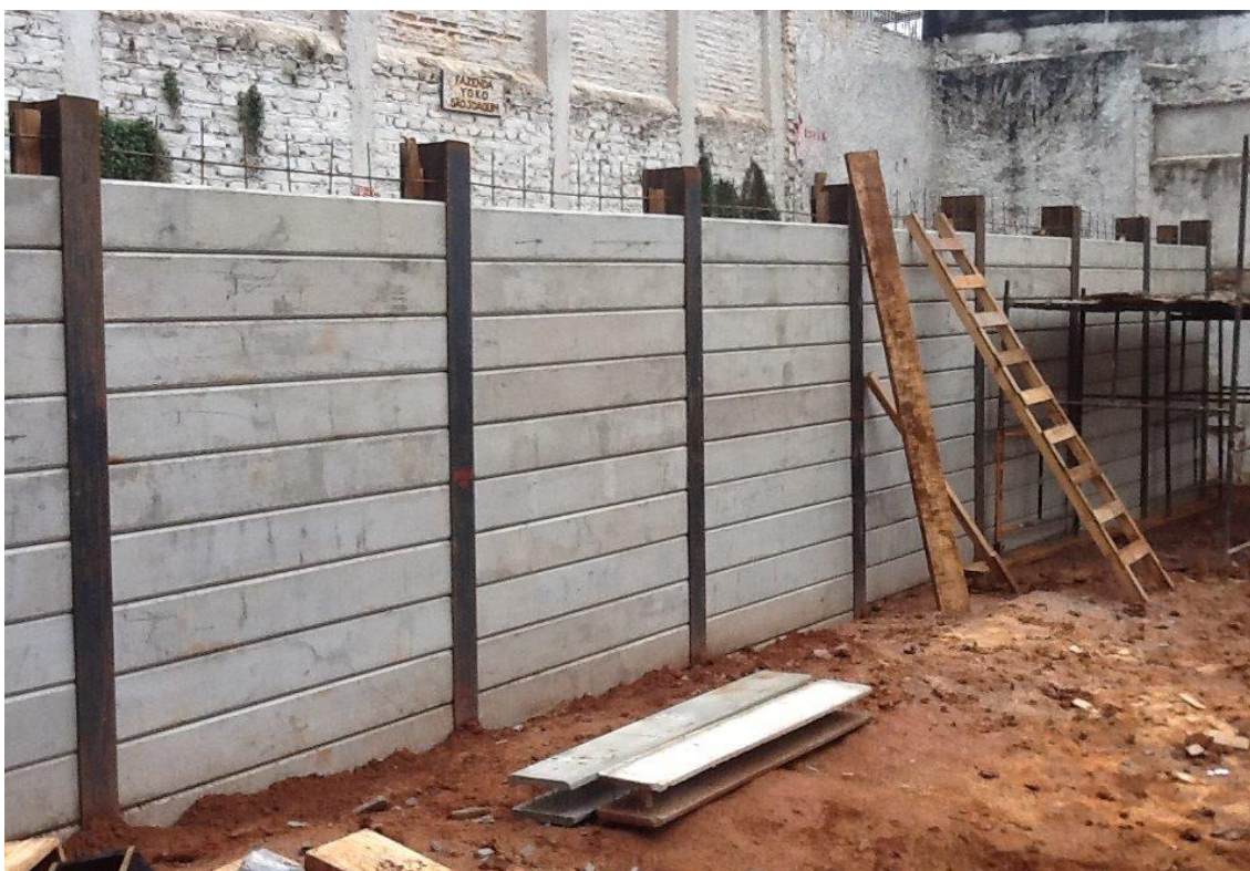
Figura 4 - Painel contenção concreto pré- moldado
