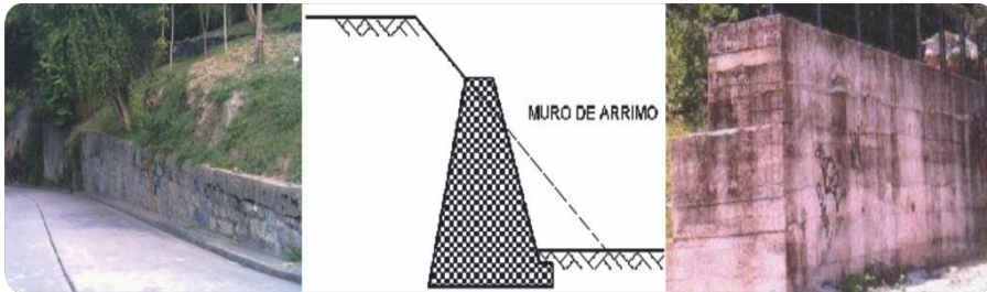
Figura 5 - Muro de arrimo gravidade
