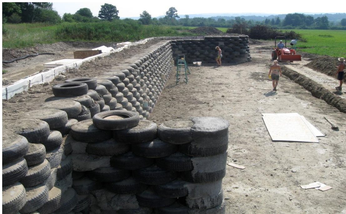
Figura 7 - Muro de gravidade de pneus
