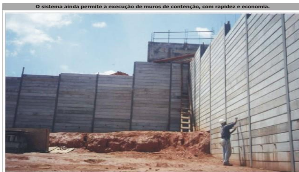
Figura 2 - Contenção pré-moldado tipo laje treliça
