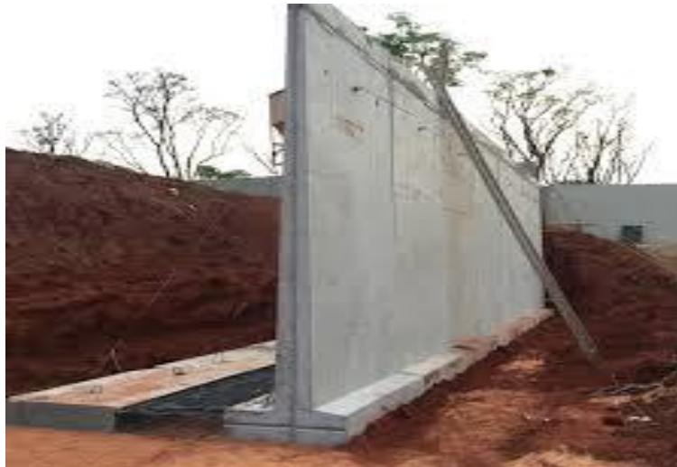
Figura 9 - Muro de arrimo por flexão
