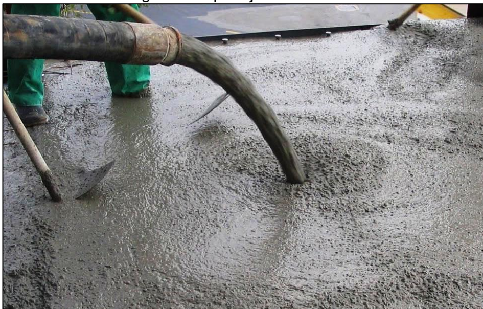
Figura 8 - Aplicação do concreto
