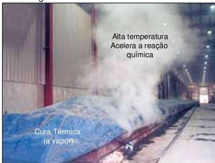
Figura 17 - Cura térmica do concreto
