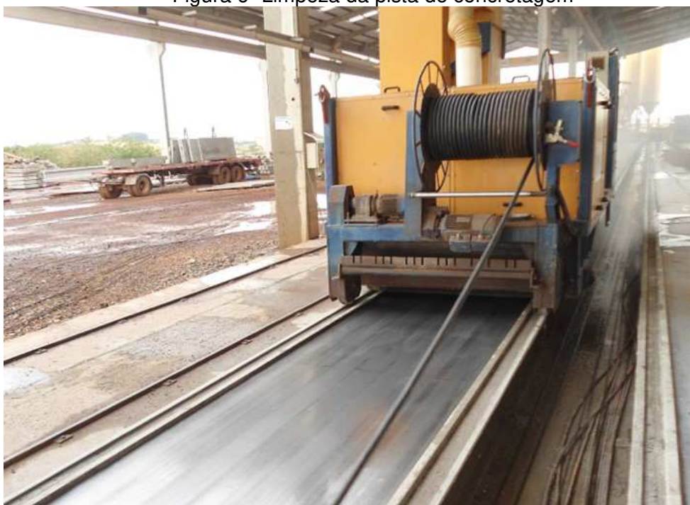
Figura 6- Limpeza da pista de concretagem
