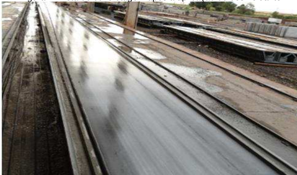
Figura 7- Pista de concretagem após a aplicação do desmoldante
