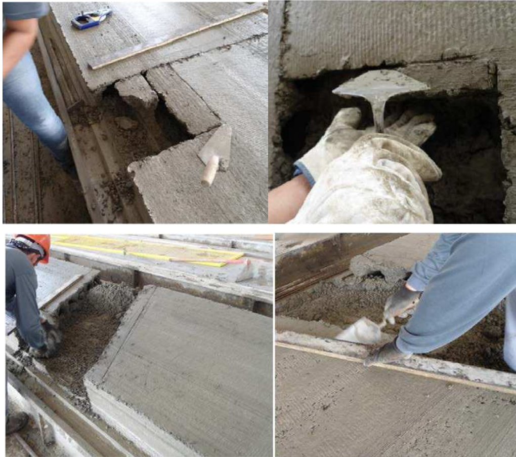
Figura 16: Execução dos cortes e aberturas
