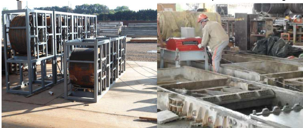
Figura 8: Posicionamento das cordoalhas sobre a pista de concretagem
