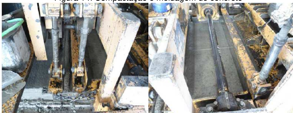
Figura 14: Compactação e moldagem do concreto
