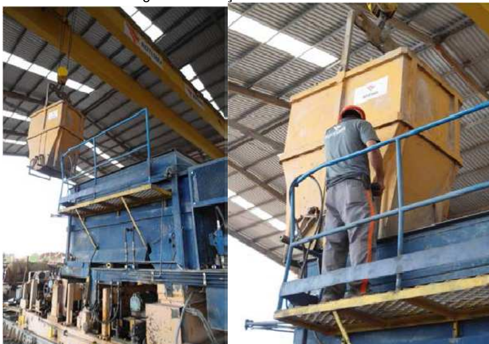
Figura 13: Lançamento do concreto
