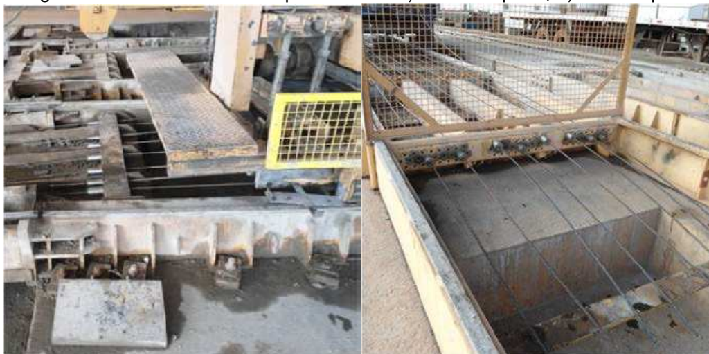
Figura 10: Cabos ancorados por cunhas. a) início da pista; b) final da pista
