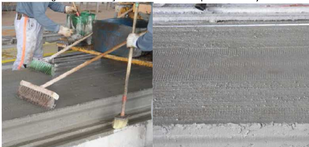
Figura 15: Execução de ranhuras na superfície das lajes
