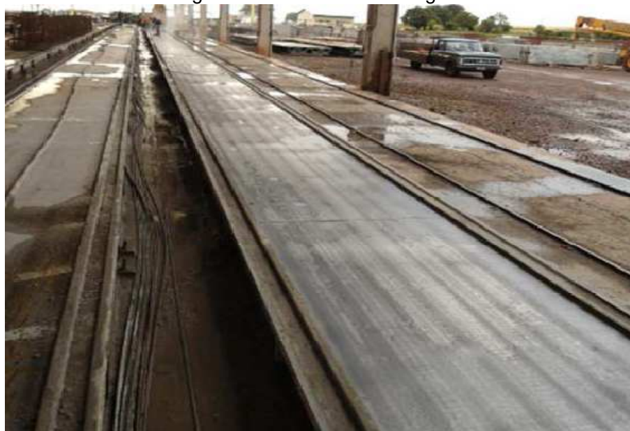
Figura 5- Pista de Concretagem
