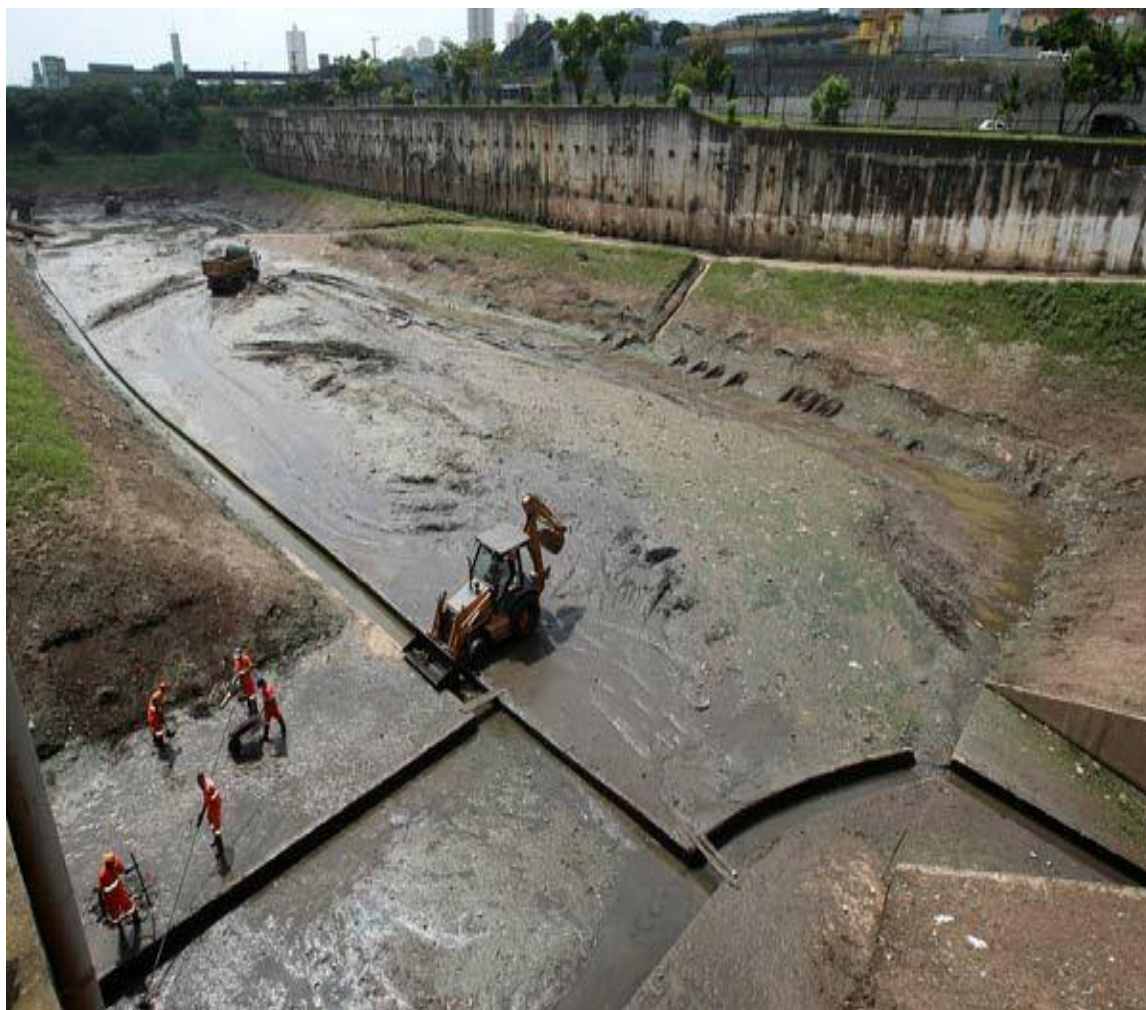
Figura 22 - Limpeza de piscinão
