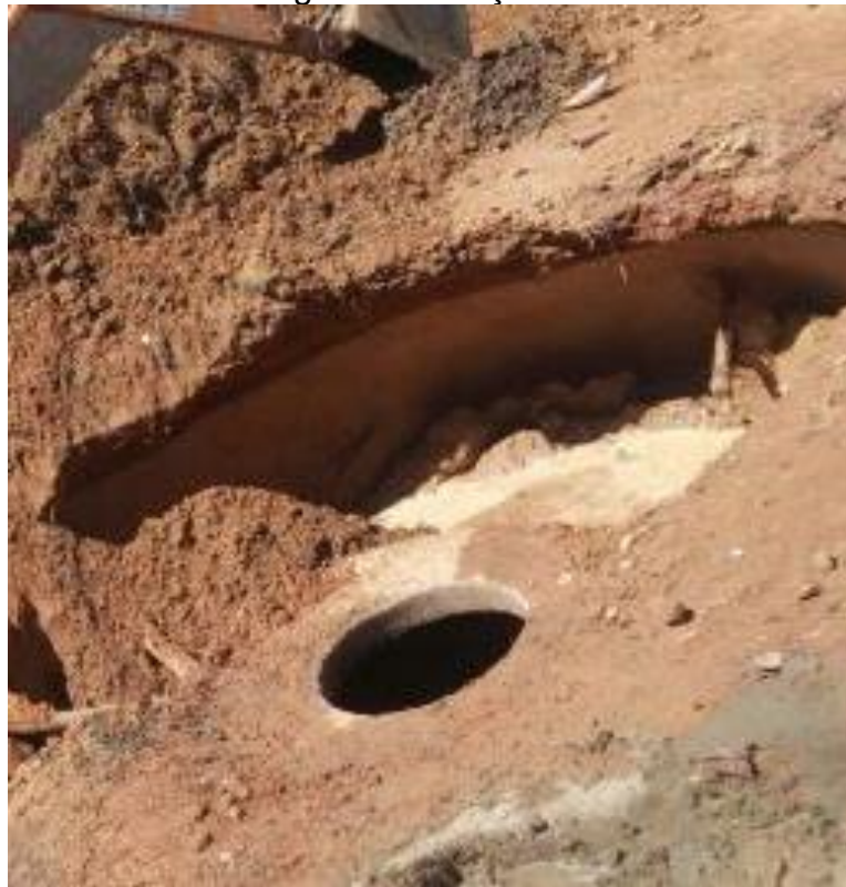
Figura 17 - Poços de visita
