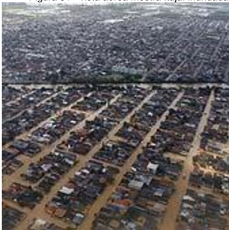
Figura 31 - vista aérea mostra Itajaí inundada
