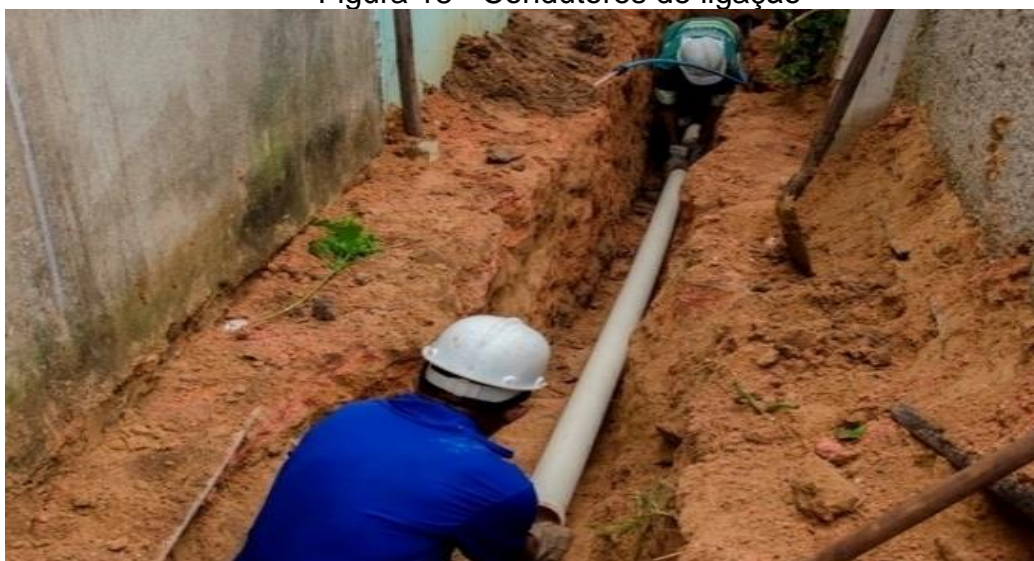
Figura 18 - Condutores de ligação
